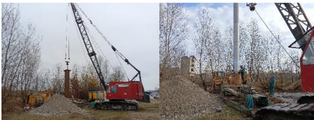
Izdelava vodnjakov za koriščenje geotermalne energije
