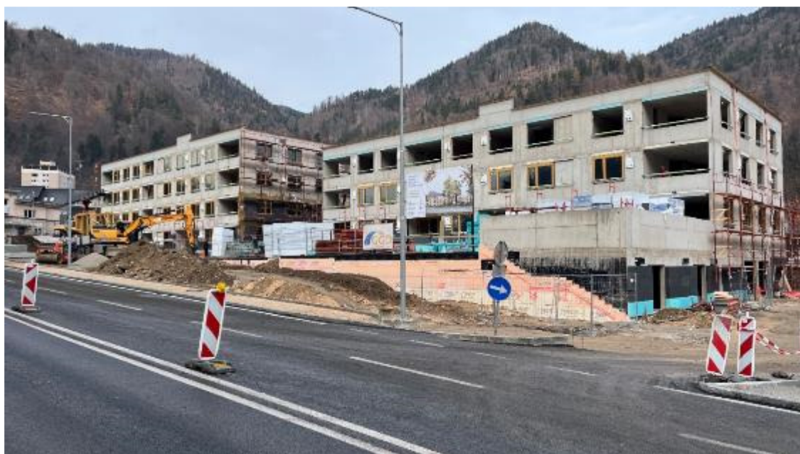
Jesenice, Partizan – gradbišče
