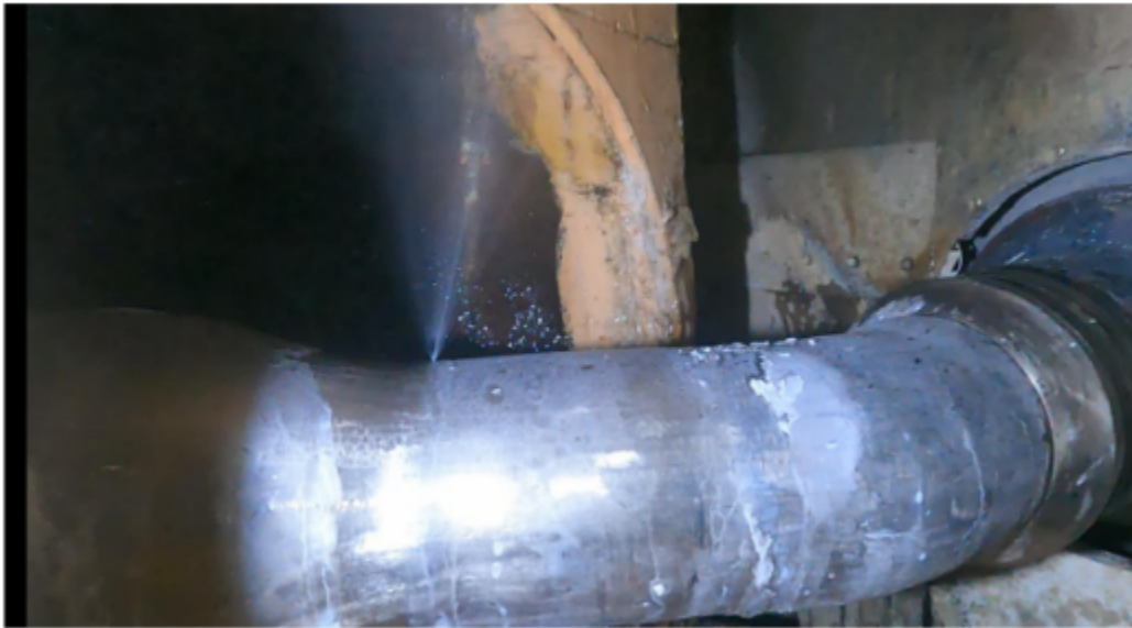
Slika 13: Mesto puščanja na zvaru
