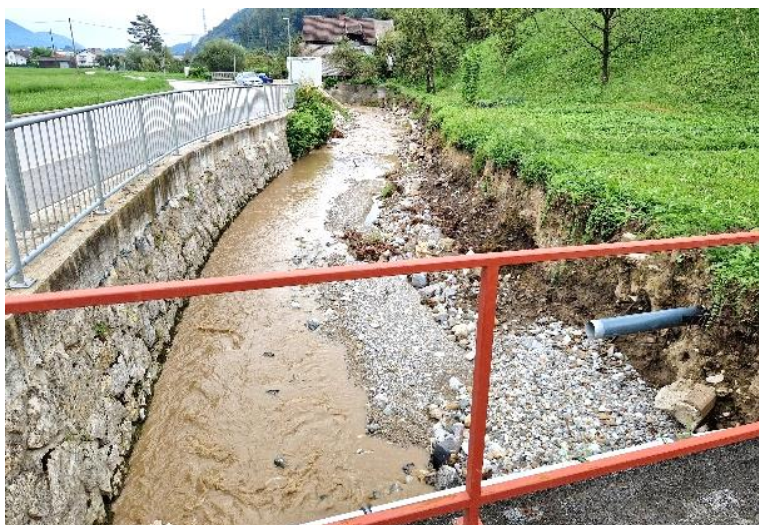
Pred izvedbo del
