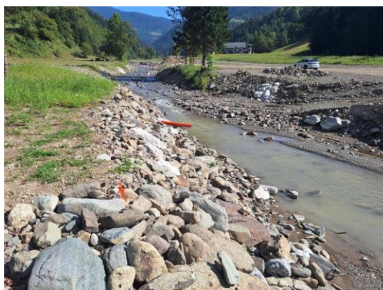
Pred izvedbo del
