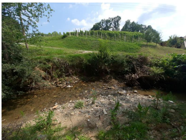
Zajeda brežine, odnos brežine, poškodbe vegetacije v bližini cestne infrastrukture
