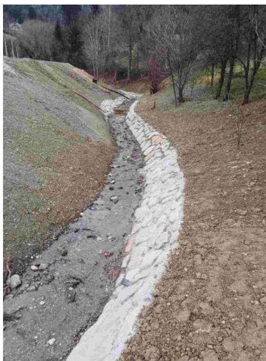
Po izvedbi del.
