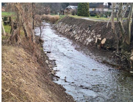
Po izvedbi del
