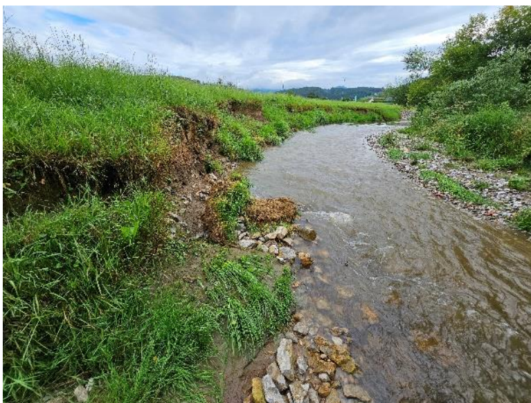
Pred izvedbo del
