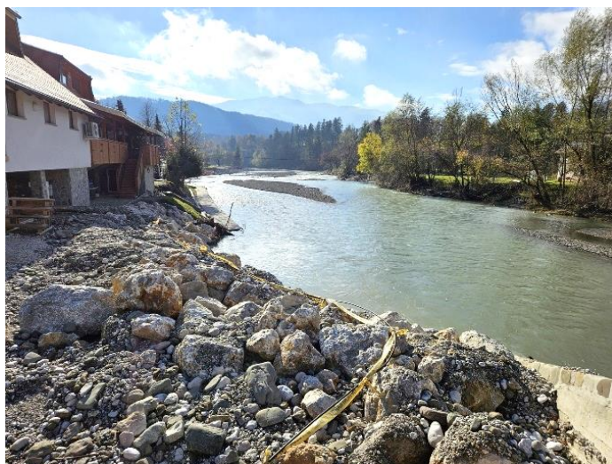
Pred izvedbo del
