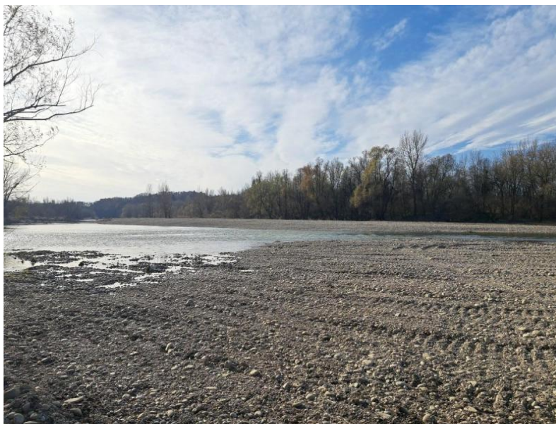
Drava - sipina pod jezo Markovci 3 po izvedbi del
