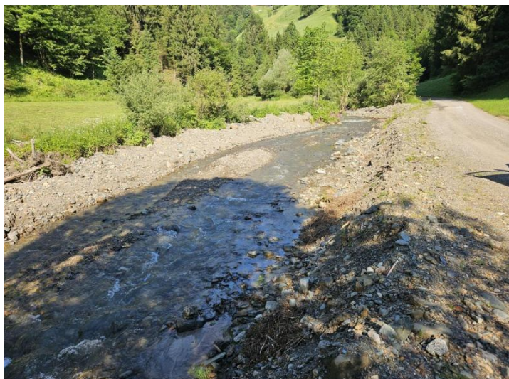
Pred izvedbo del
