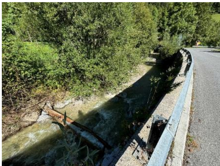
Pred izvedbo del
