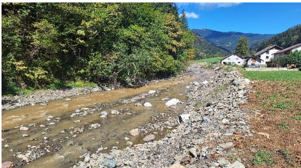
Pred izvedbo del
