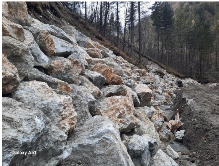
Po izvedbi del
