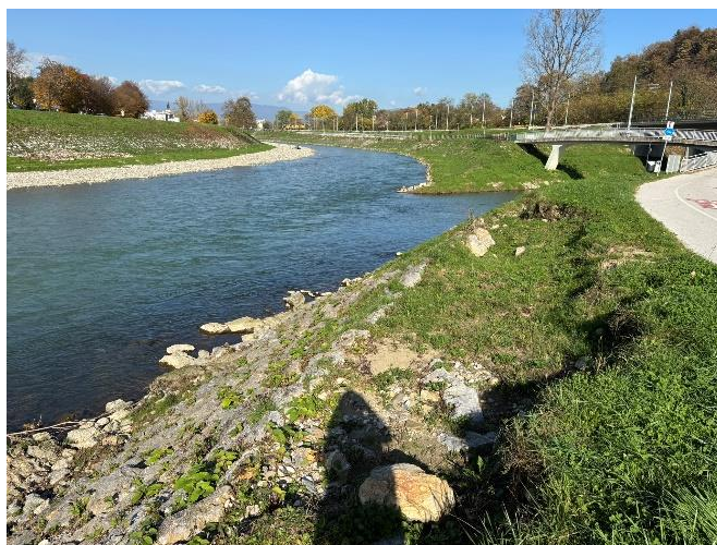
Pred izvedbo del
