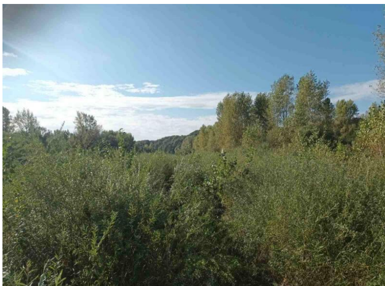
Drava - sipina pod jezo Markovci 3 pred izvedbo del
