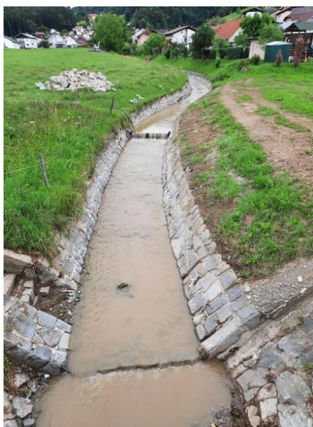
Po izvedbi del.
