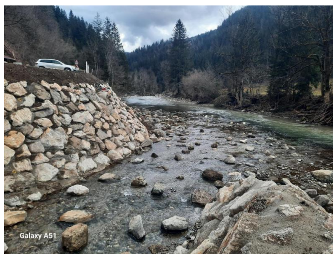
Po izvedbi del
