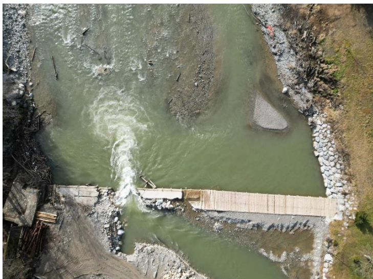
Pred izvedbo del
