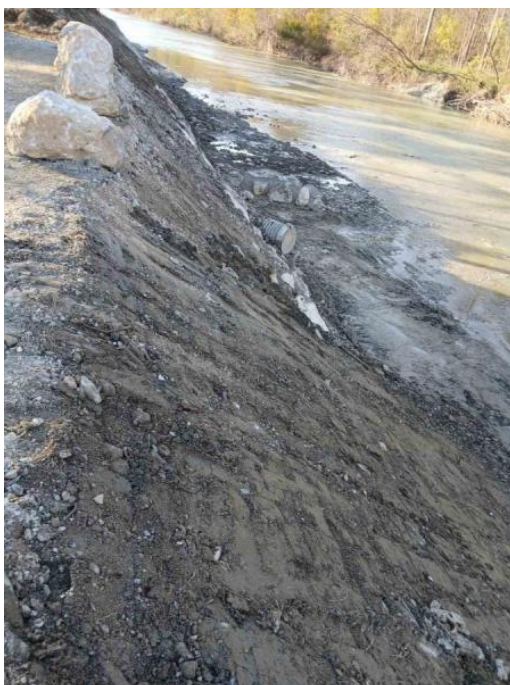
Po izvedbi del
