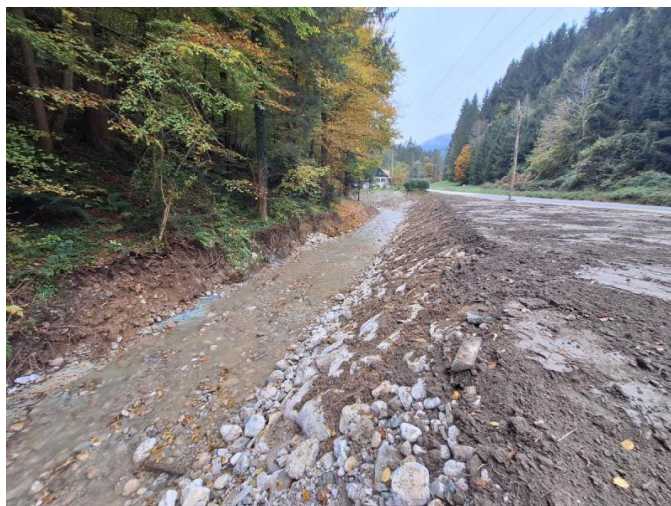
Pred izvedbo del
