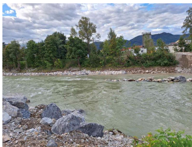
Pred zaključkom del
