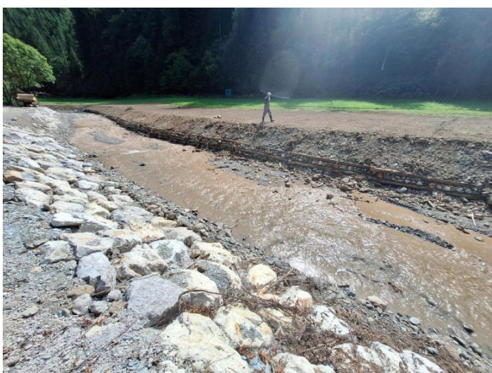
Po izvedbi del
