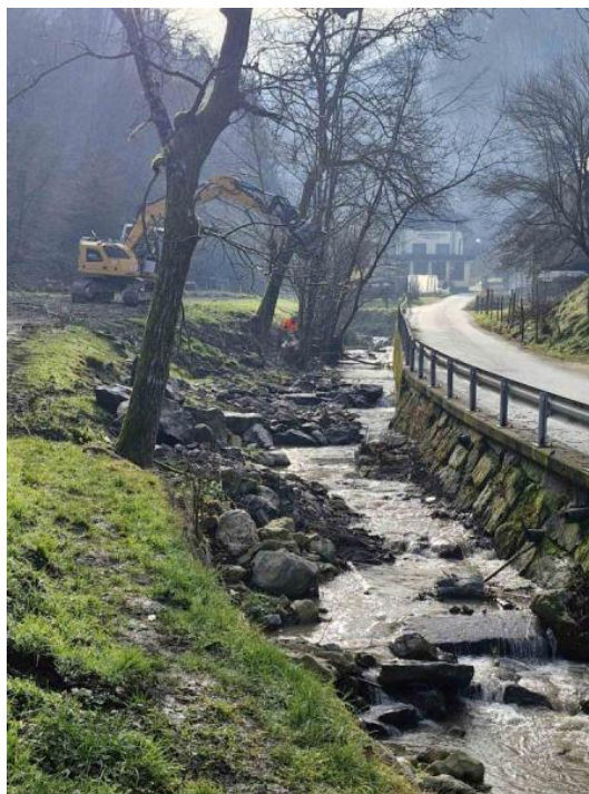
Med izvedbo - pogled gorvodno.
