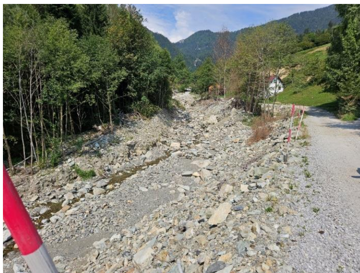
Pred izvedbo sanacije
