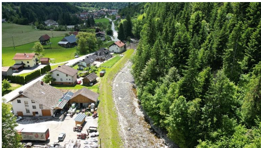
Po izvedbi del
