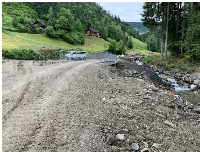
Pred izvedbo del
