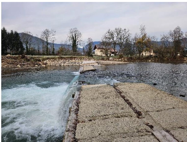
Pred izvedbo del
