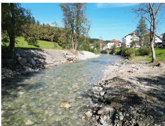
Po izvedbi del
