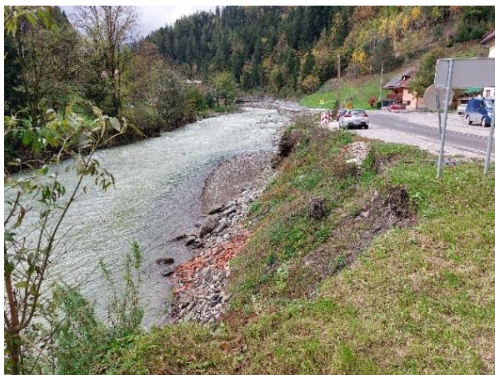
Pred izvedbo del
