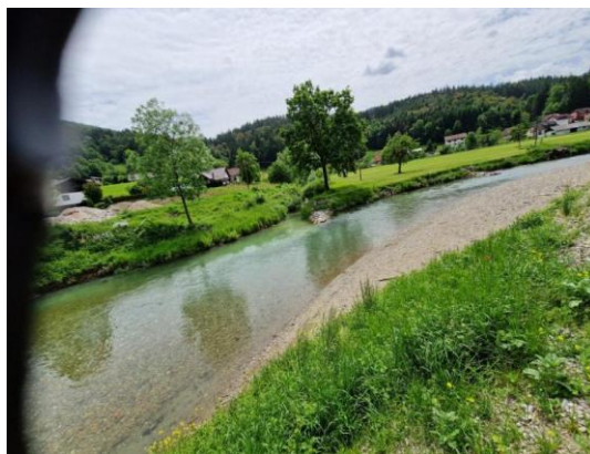
Pred izvedbo del
