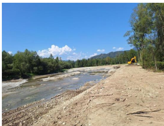
Po izvedbi del
