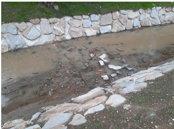
Po izvedbi del.
