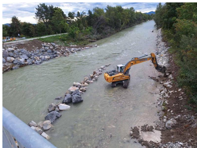
Pred zaključkom del
