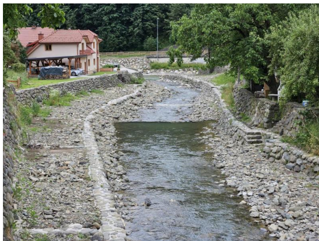
Pred izvedbo del
