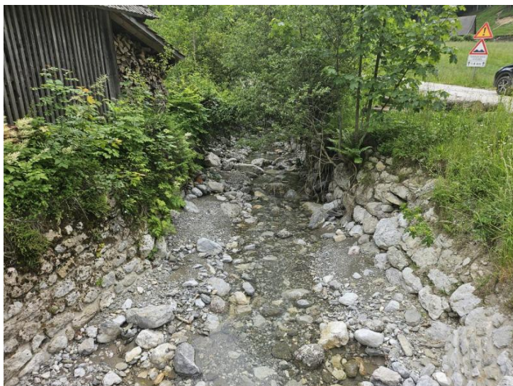
Pred izvedbo del
