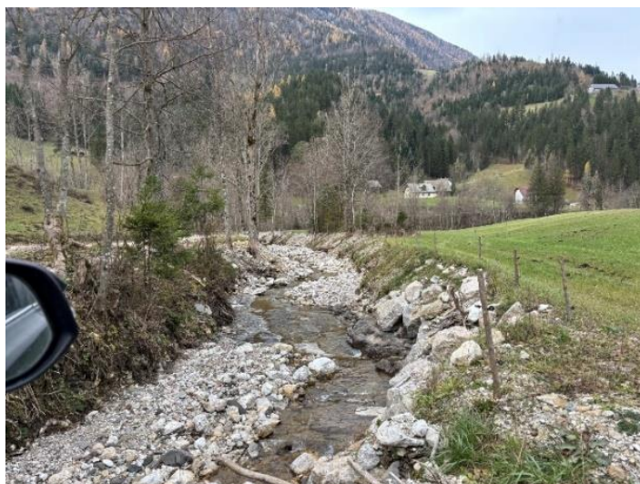
Pred izvedbo del
