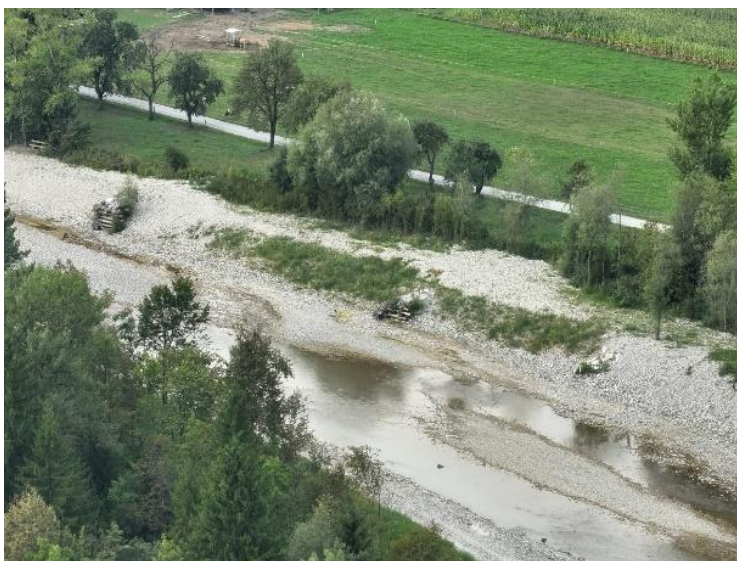
Pred izvedbo del
