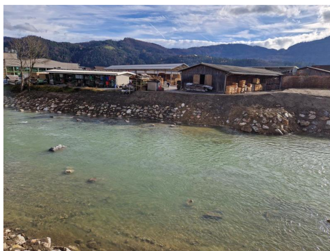
Po izvedbi del
