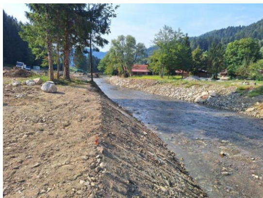
Po izvedbi del
