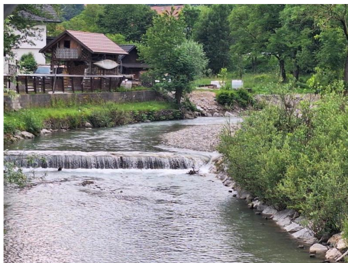
Pred izvedbo del
