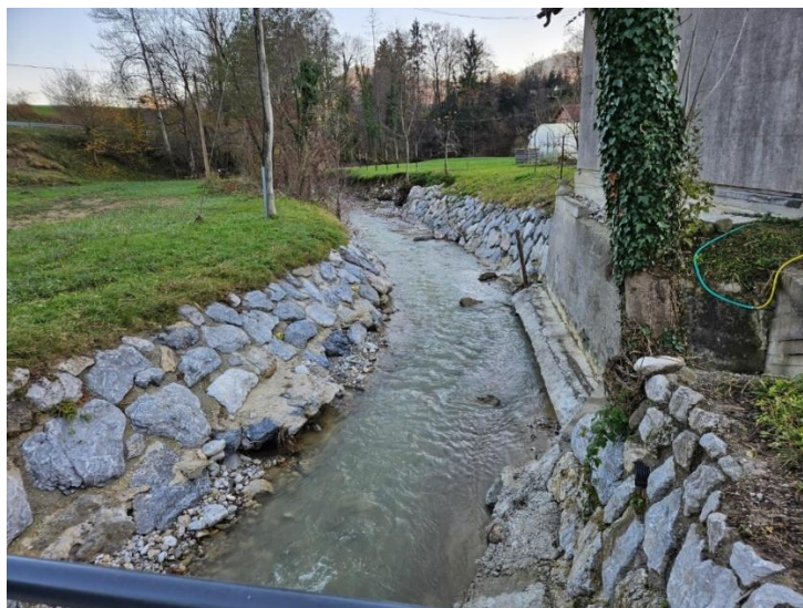
Po izvedbi del
