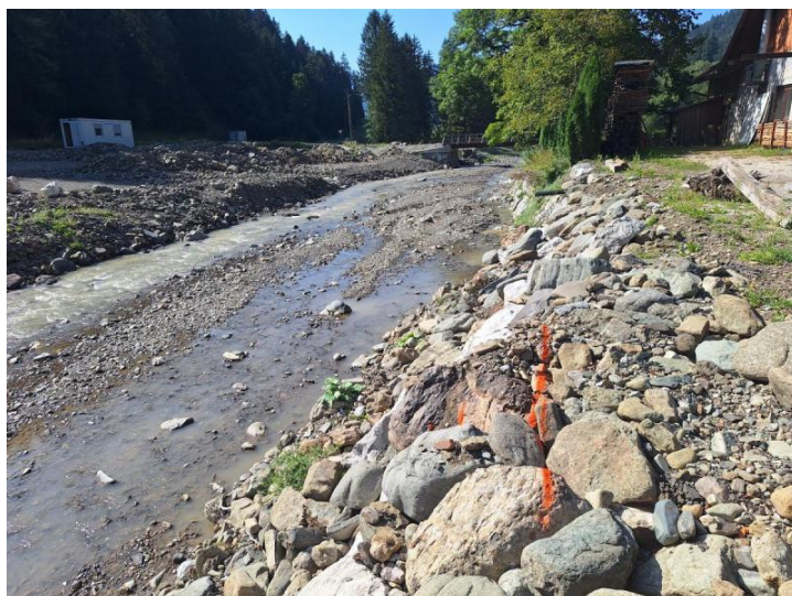
Pred izvedbo del
