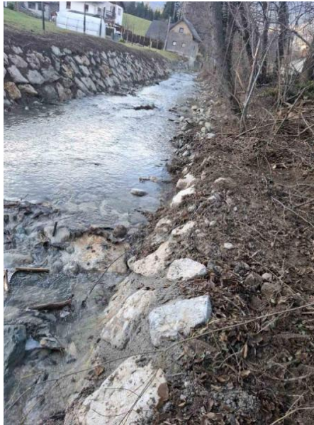
Po izvedbi del
