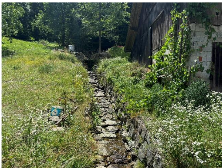
Pred izvedbo del
