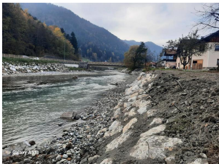
Po izvedbi del
