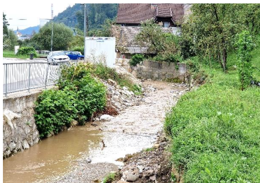
Po izvedbi del
