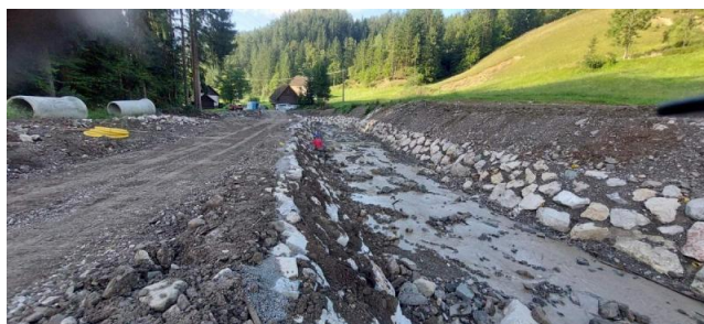
Po izvedbi del
