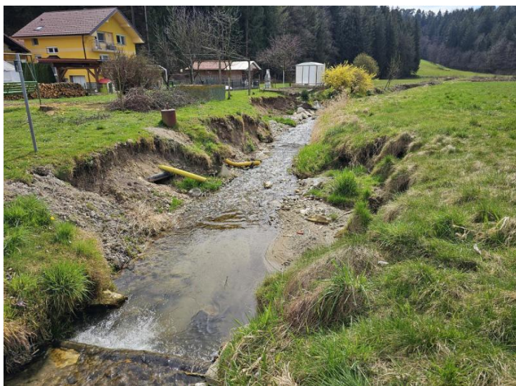
Pred izvedbo del
