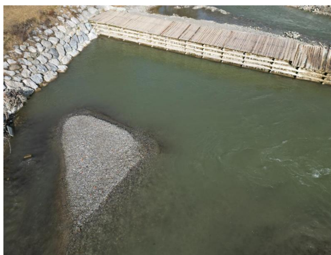
Po izvedbi del
