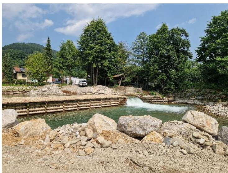
Po izvedbi del
