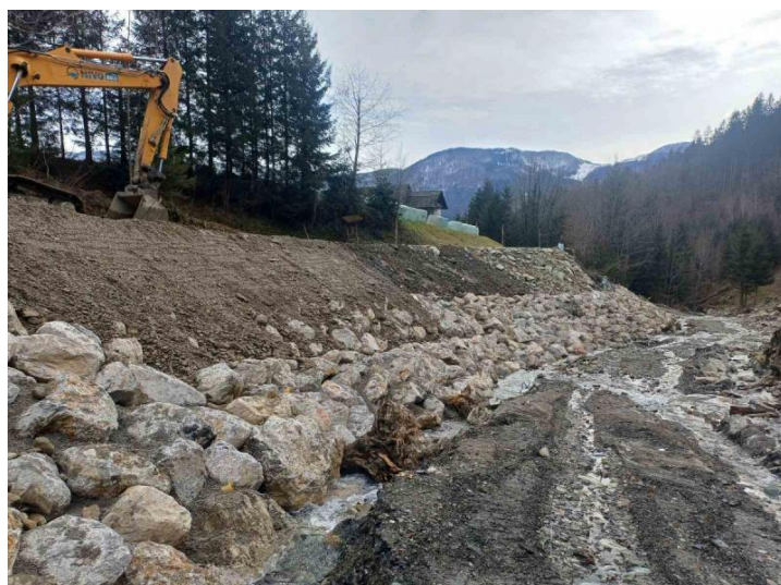
Med izvedbo sanacije
