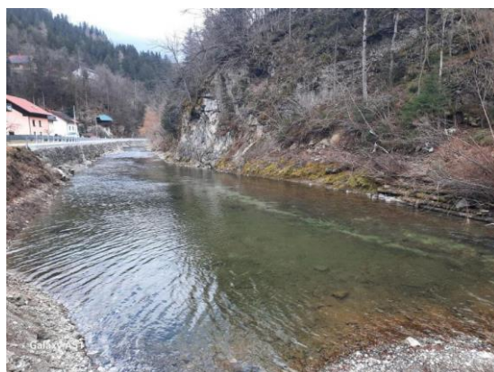
Po izvedbi del
