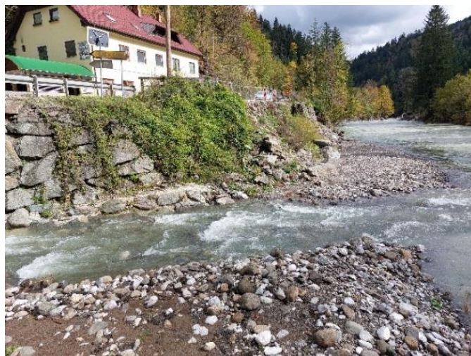
Pred izvedbo del
