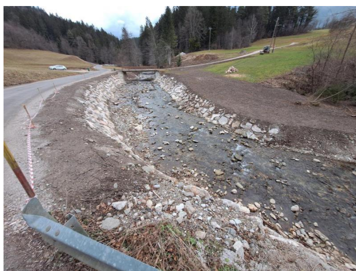
Po izvedbi del
