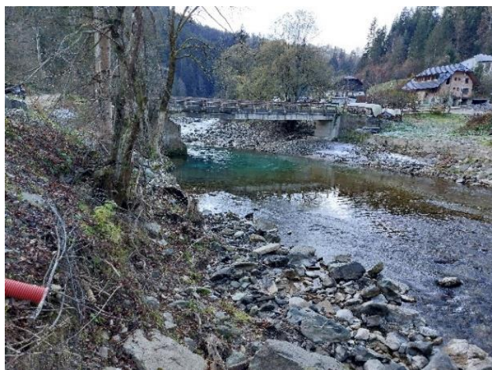
Pred izvedbo del
