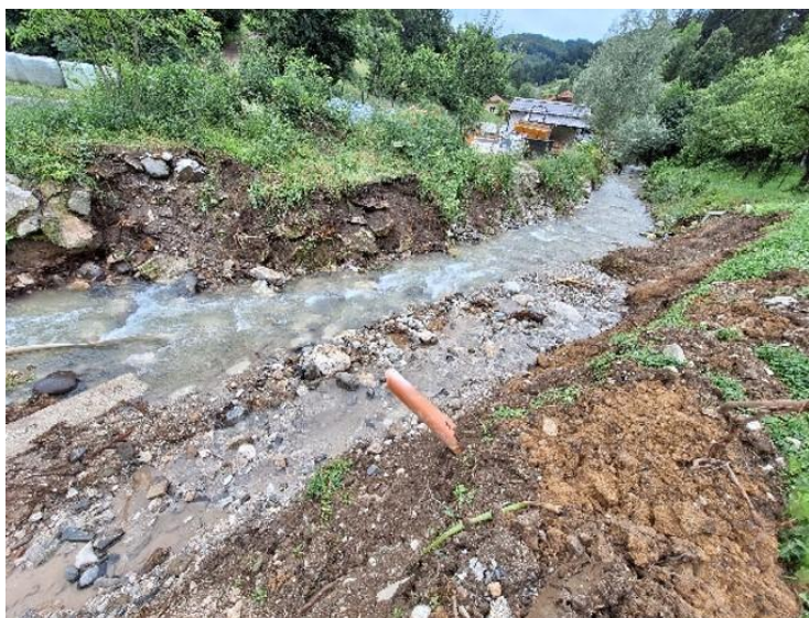
Pred izvedbo del
