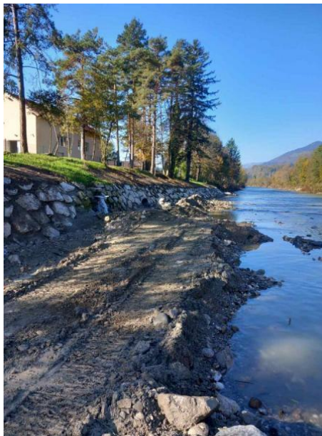
Po izvedbi del
