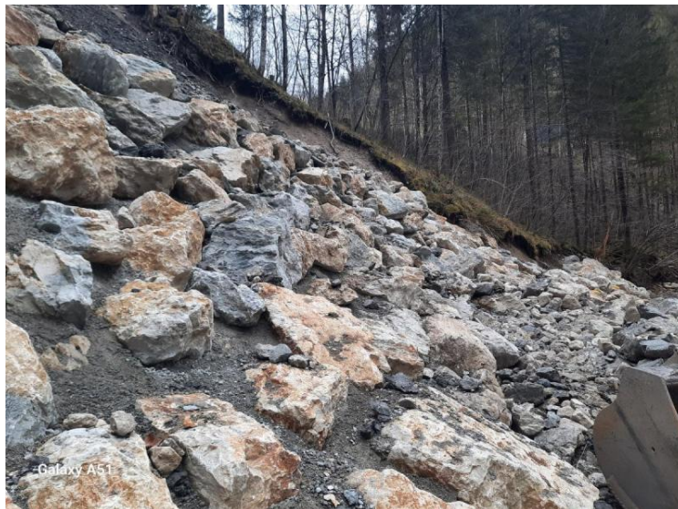
Po izvedbi del
