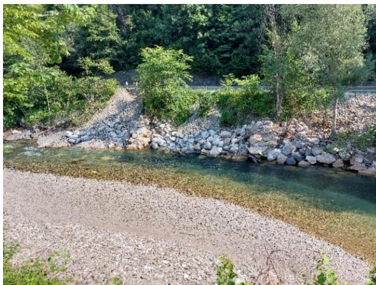
Pred izvedbo del
