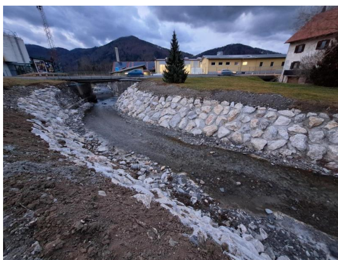
Po izvedbi del
