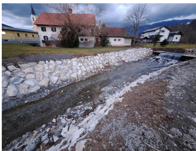
Po izvedbi del
