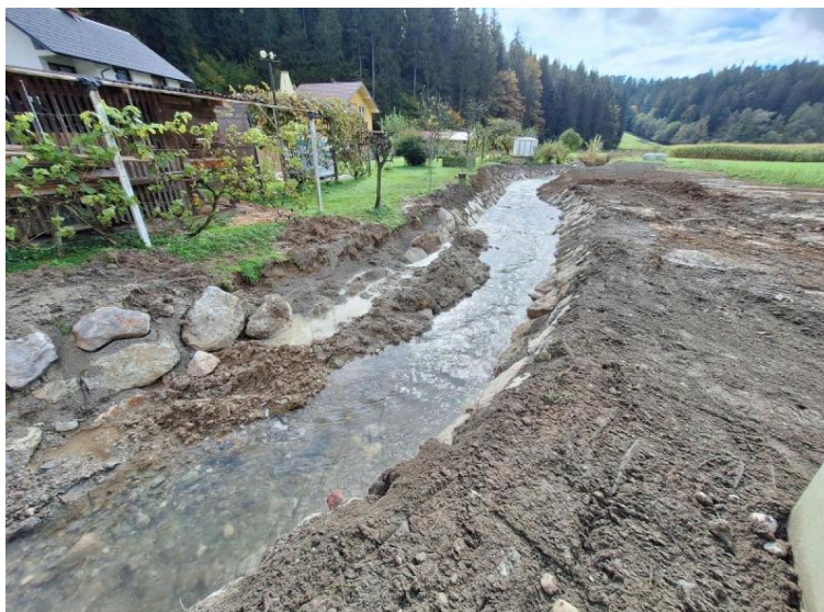
Pred zaključkom del
