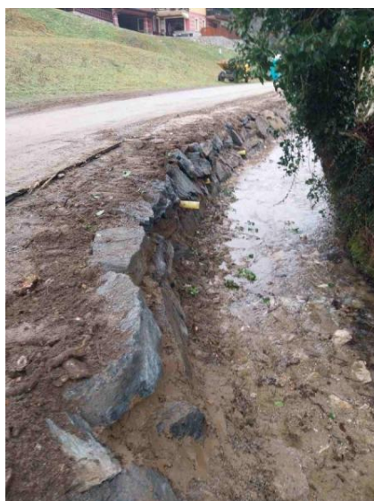
Sanacija erozije, obrežno zavarovanje tekom izvajanja.
