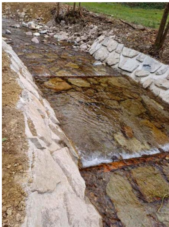
Po izvedbi del.
