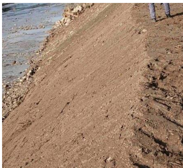
Sanacija LB Savinje
