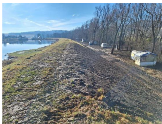
Nasip po sanaciji
