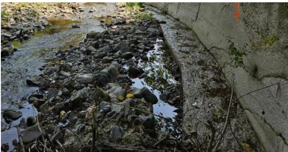
Pred izvedbo del
