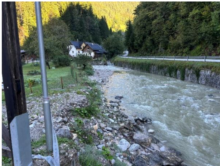
Pred izvedbo del
