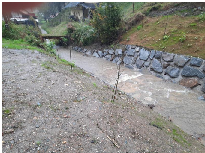
Po izvedbi del.
