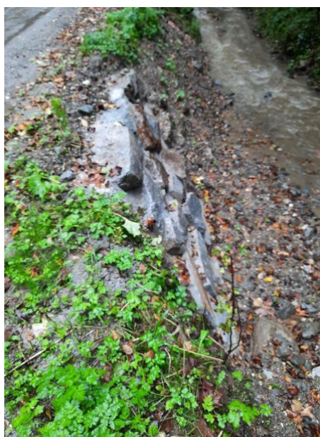
Po izvedbi del.
