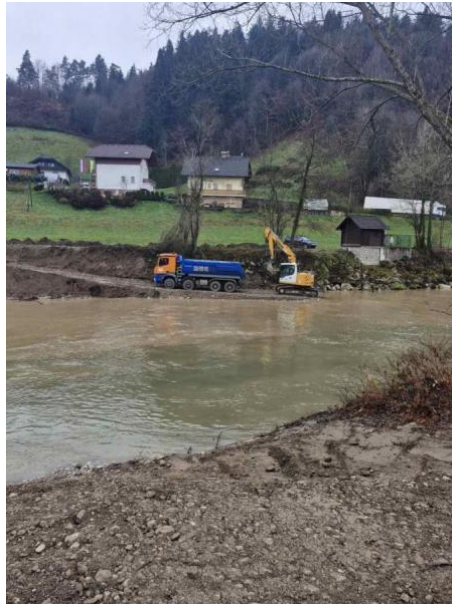
Med izvedbo - pogled gorvodno.
