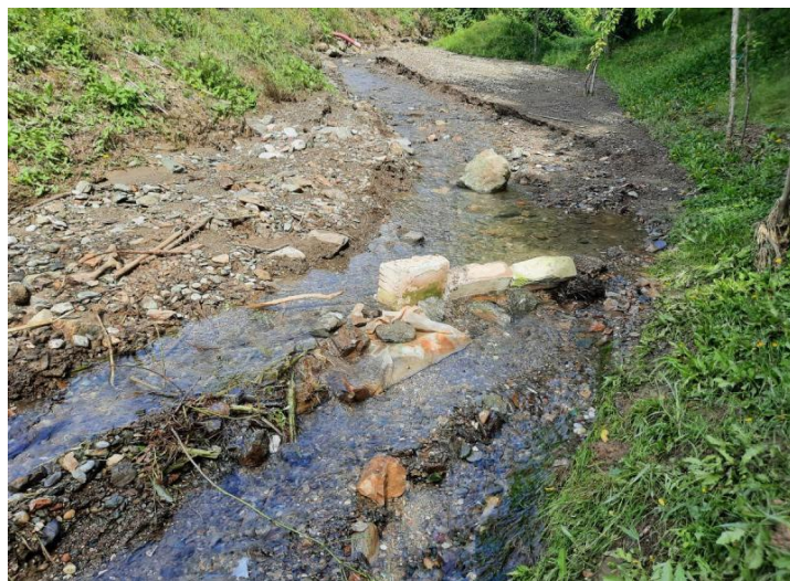
Pred izvedbo del.
