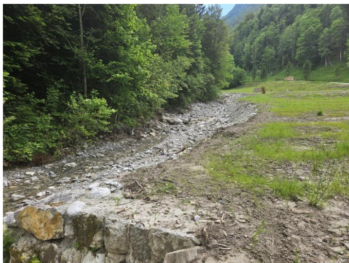
Pred izvedbo del
