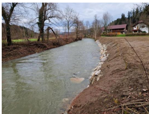
Po izvedbi del
