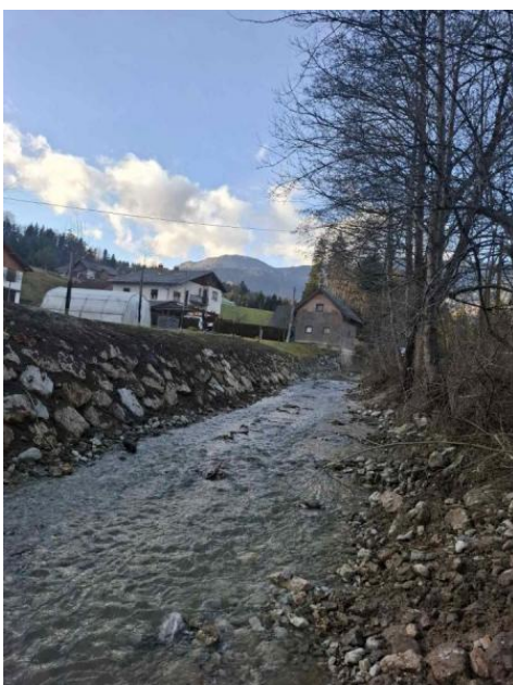
Pred izvedbo del
