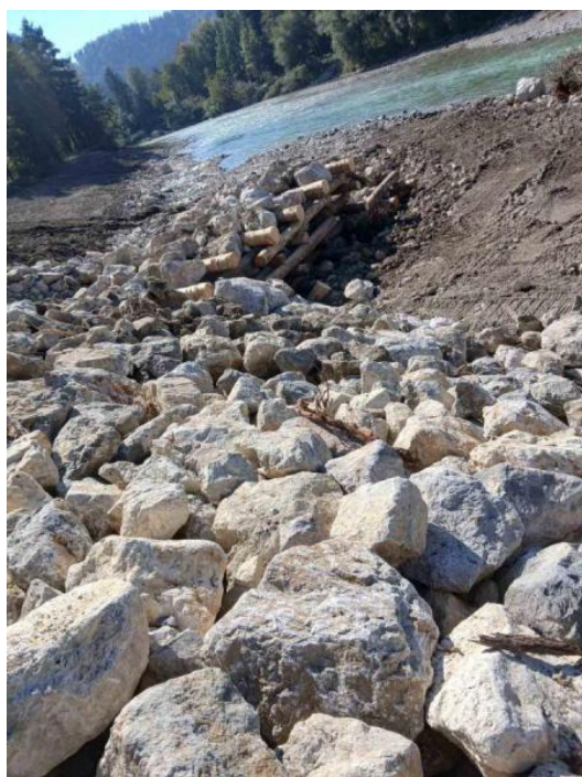
Po izvedbi del
