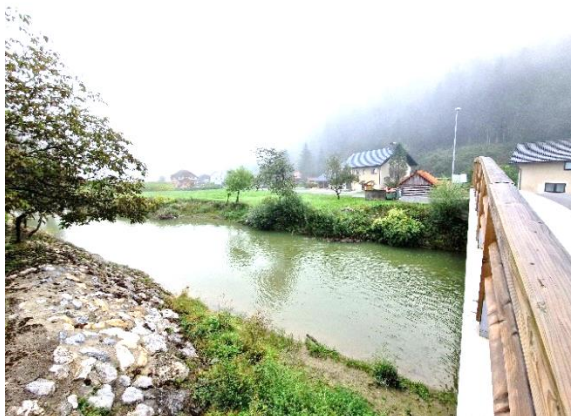
Pred izvedbo del
