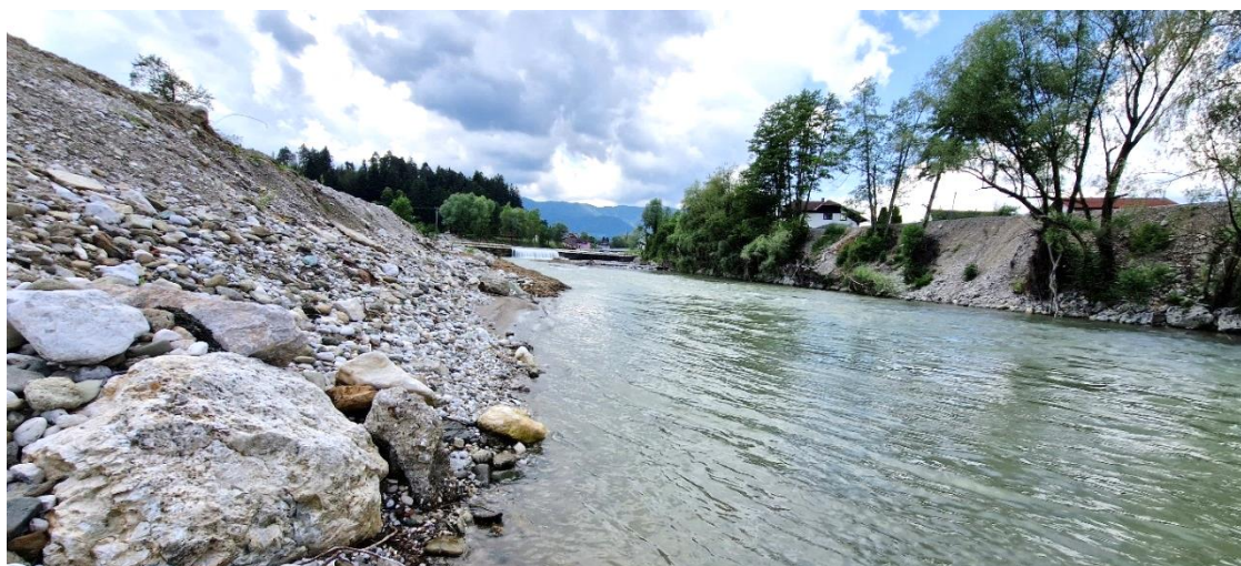
Pred izvedbo del
