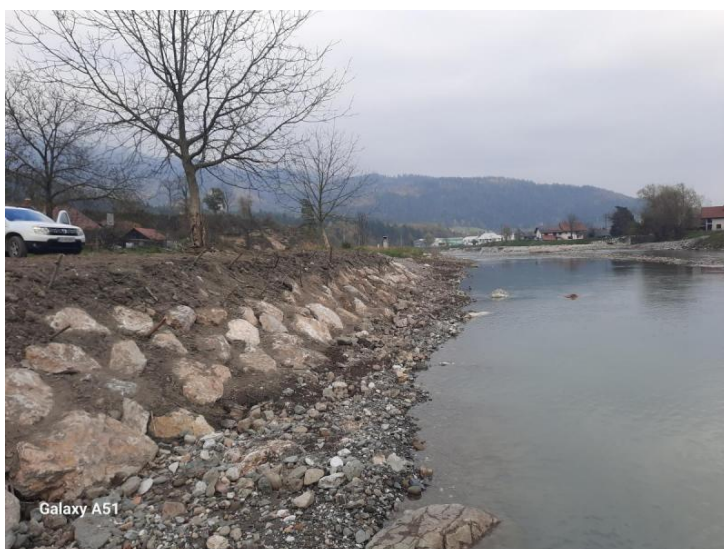
Po izvedbi del
