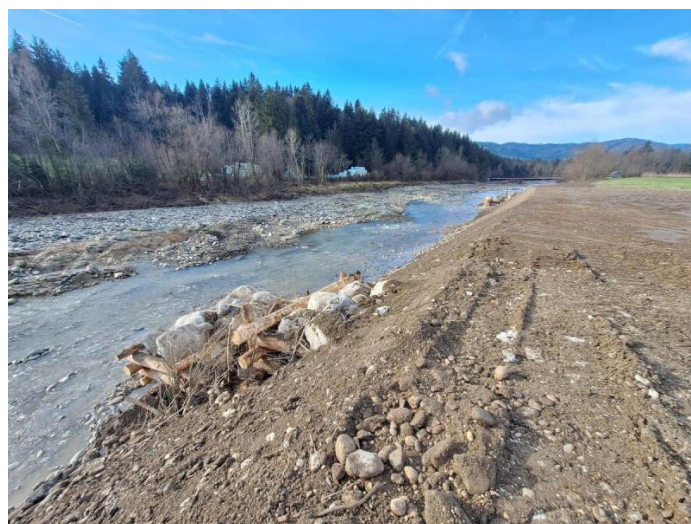
Sanacija LB Savinje
