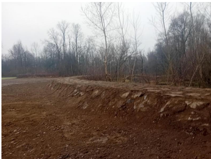
Nasip v bližini h. št. Bukovci 156 po izvedbi del.
