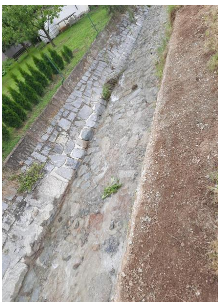
Po izvedbi del.
