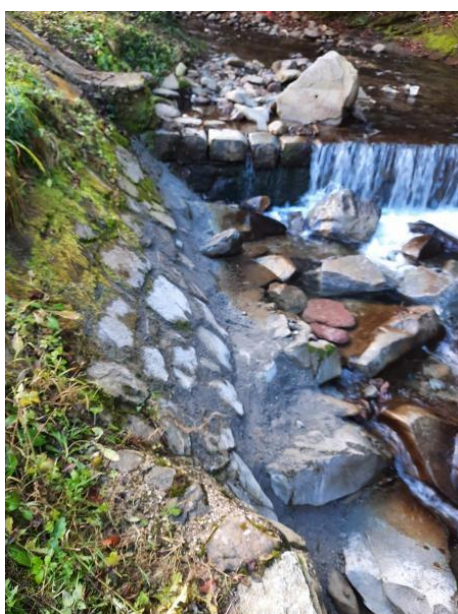
Po izvedbi del.
