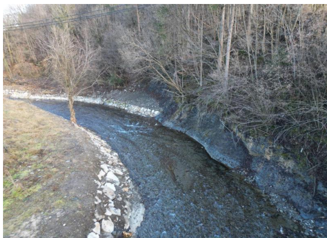
Po izvedbi del
