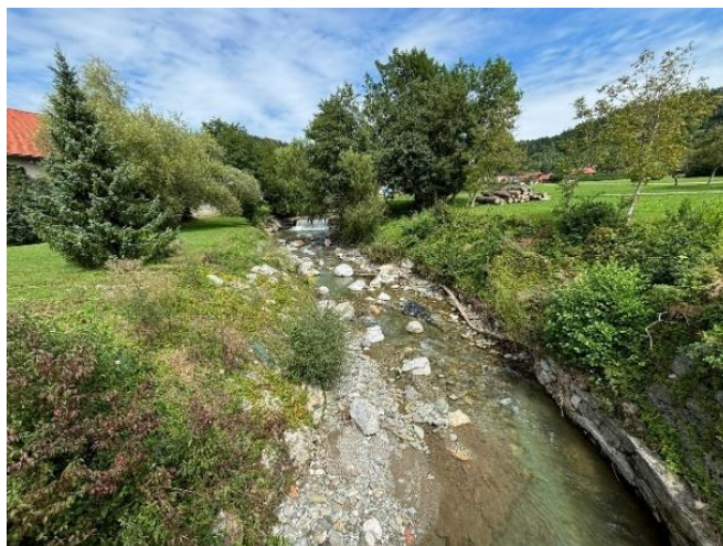
Pred izvedbo del
