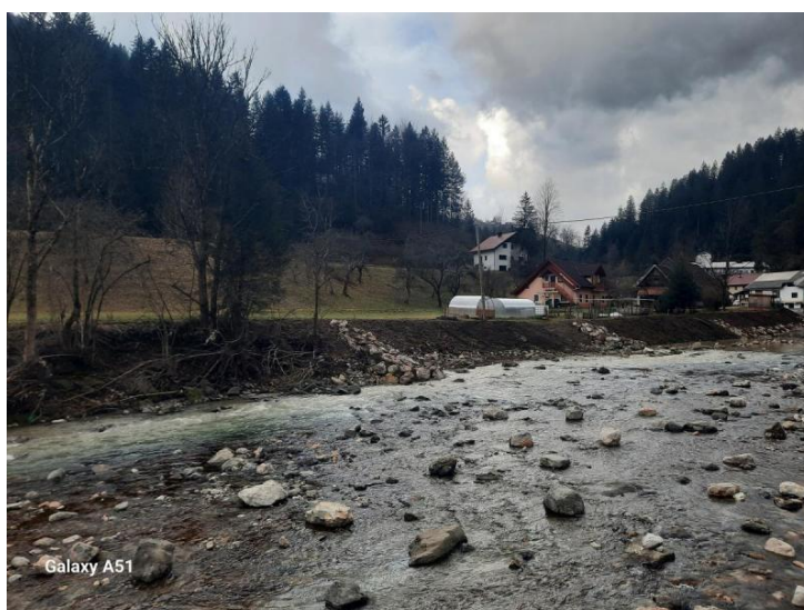
Po izvedbi del
