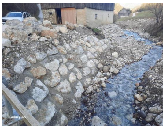
Po izvedbi del
