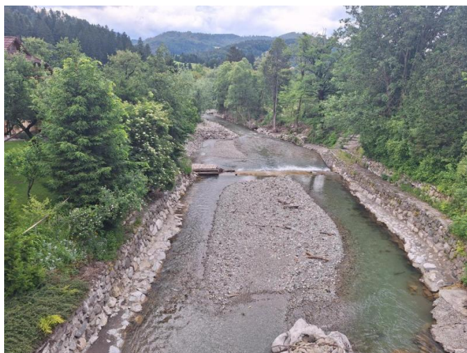
Pred izvedbo del
