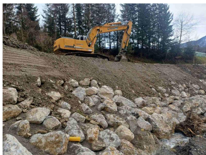
Med izvedbo sanacije
