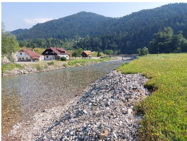
Pred izvedbo del
