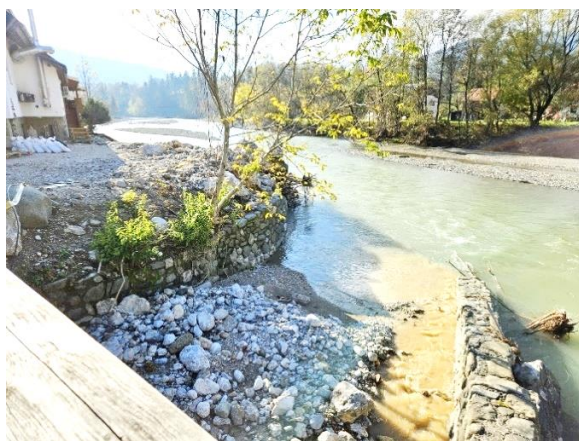
Pred izvedbo del
