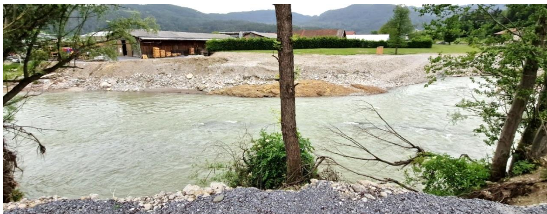
Pred izvedbo del
