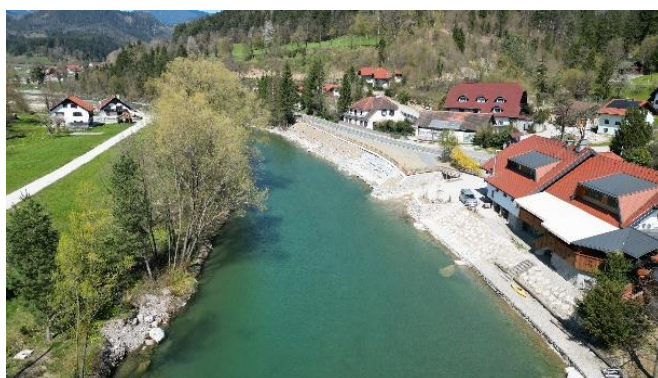
Po izvedbi del
