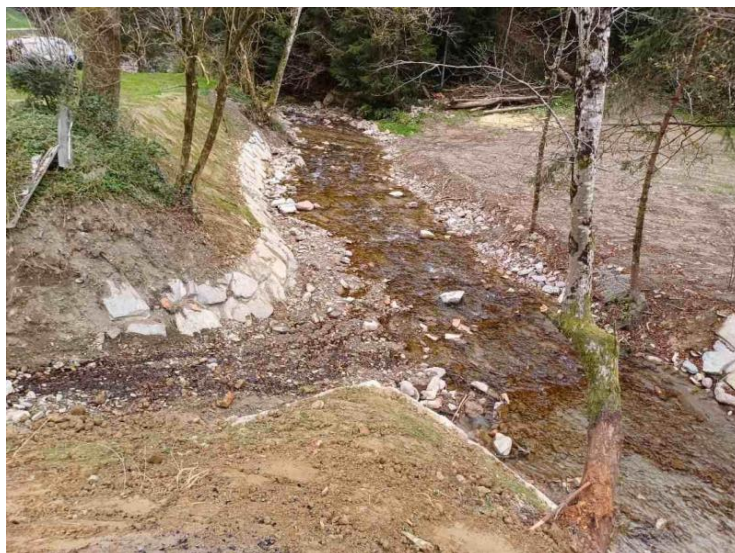
Po izvedbi del.
