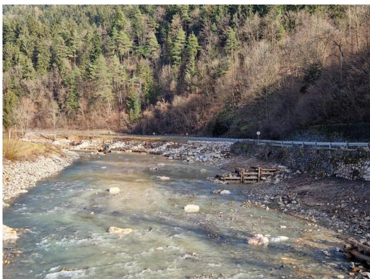
Po izvedbi del
