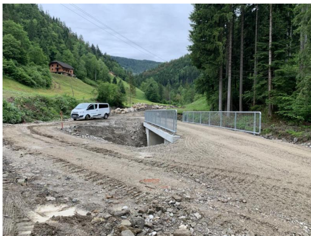
Pred izvedbo del
