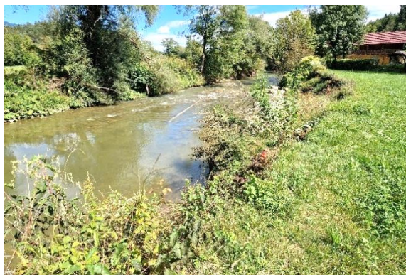
Pred izvedbo del
