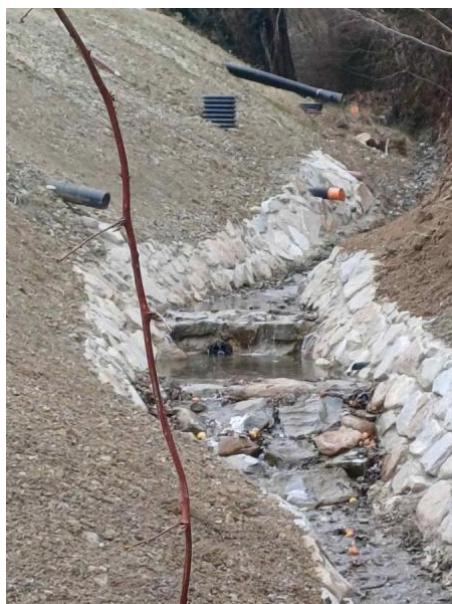
Po izvedbi del.
