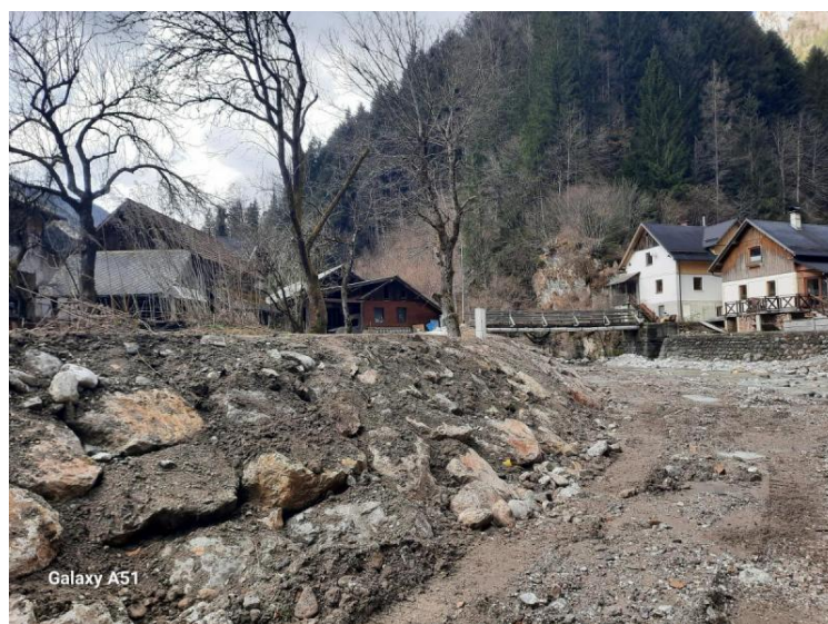
Po izvedbi del
