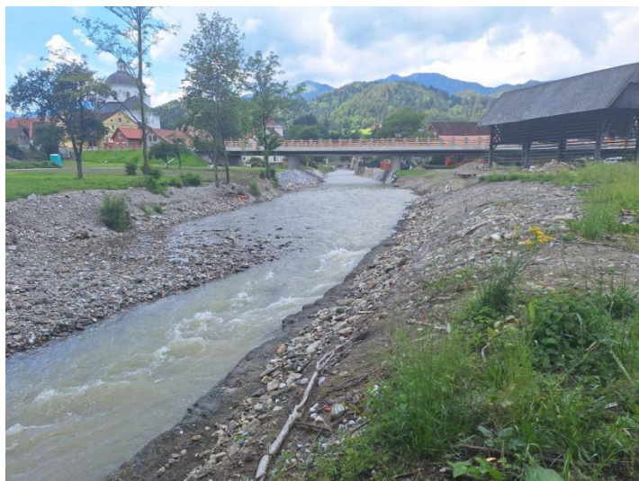
Pred izvedbo del
