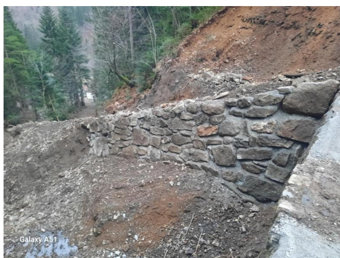
Po izvedbi del
