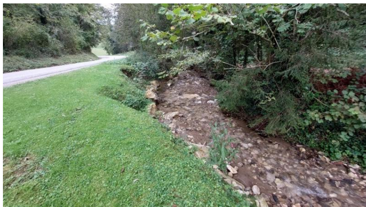
Erozija brežin in poškodbe obstoječe vodne infrastrukture
