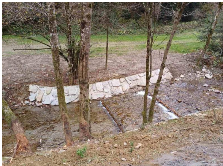
Po izvedbi del.
