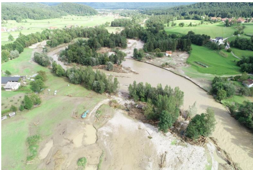
Pred izvedbo del
