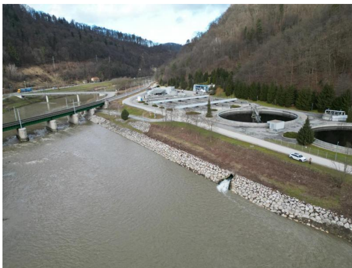
Po izvedbi del
