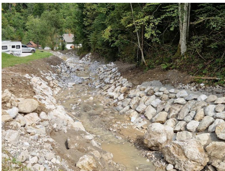
Po izvedbi del
