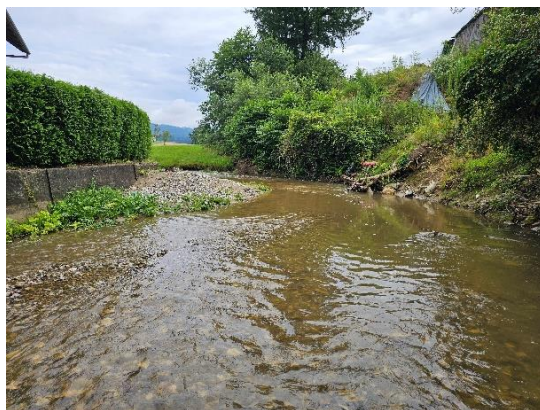
Pred izvedbo del
