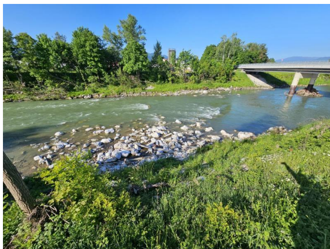
Pred izvedbo del
