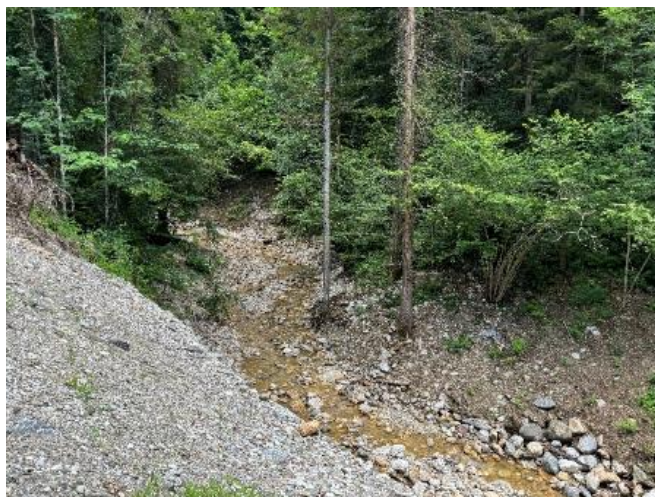
Pred izvedbo del
