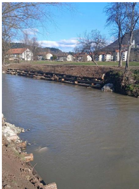
po izvedbi del
