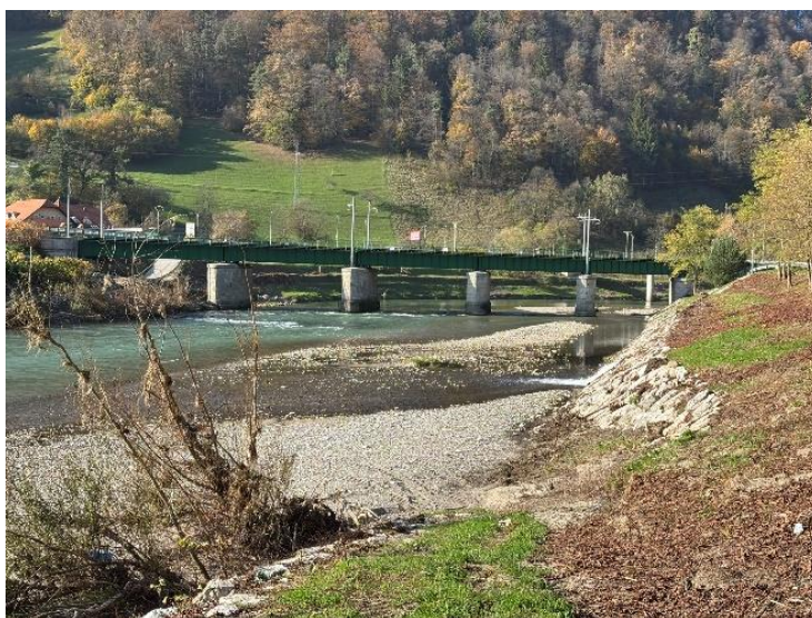
Pred izvedbo del
