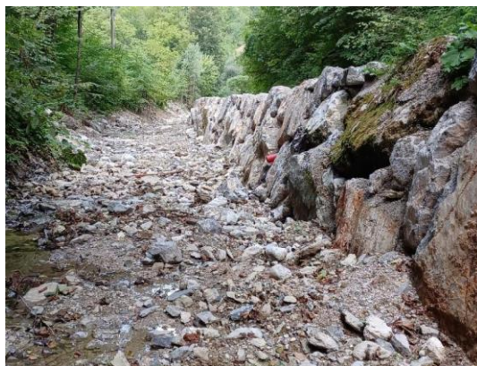
po končani sanaciji
