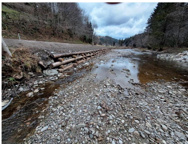
Po izvedbi del
