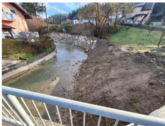
Po izvedbi del
