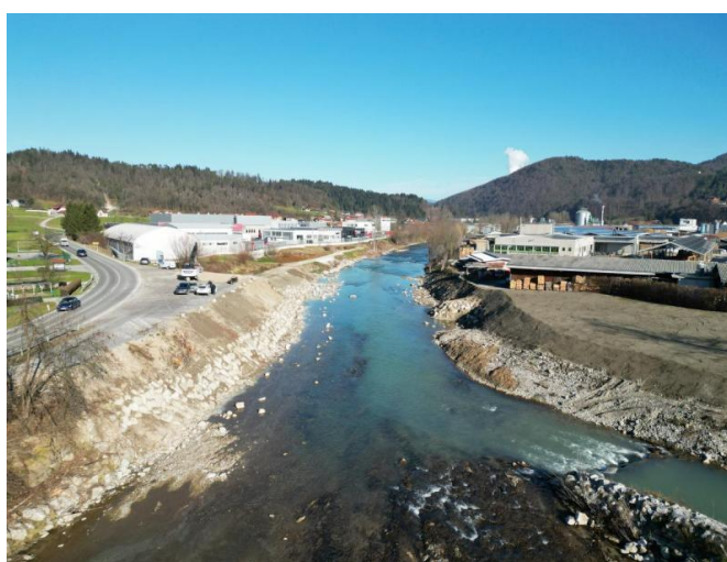
Po izvedbi del
