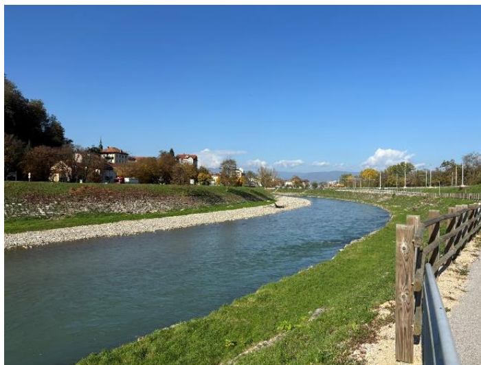
Pred izvedbo del
