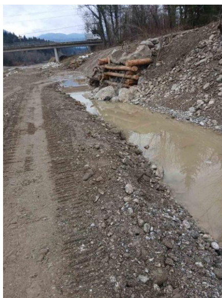
Po izvedbi del
