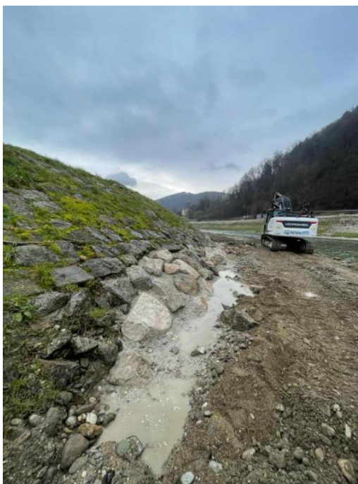
Po izvedbi del
