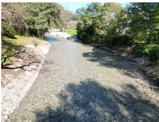
Po izvedbi del
