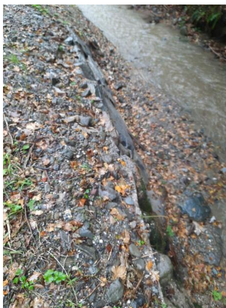
Po izvedbi del.
