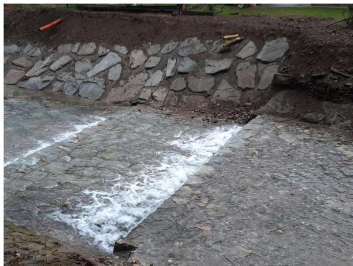
Po izvedbi del.
