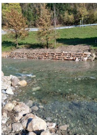
Po izvedbi del
