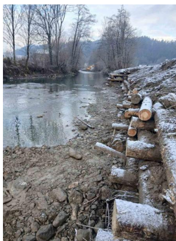
Po izvedbi del
