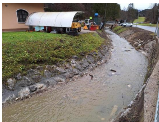
Po izvedbi del
