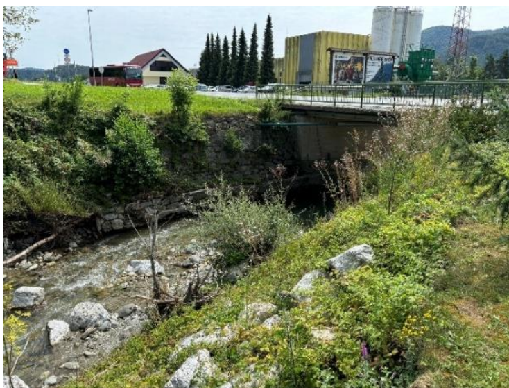
Pred izvedbo del
