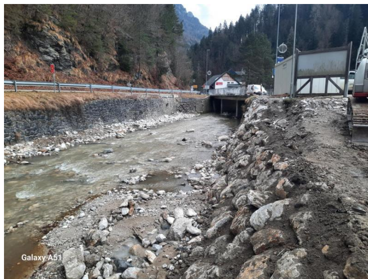
Po izvedbi del
