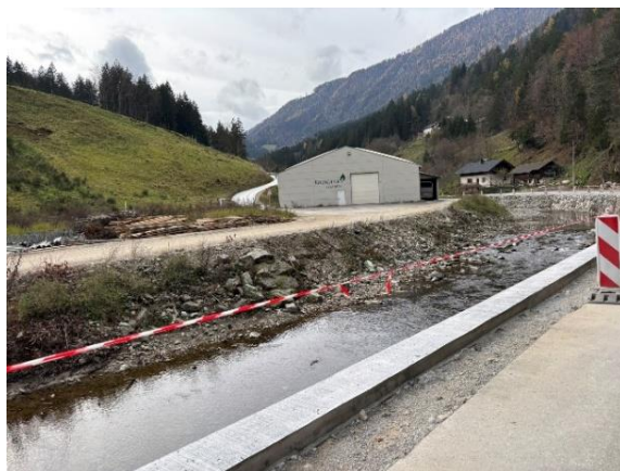
Pred izvedbo del
