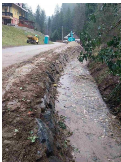
Sanacija erozije, obrežno zavarovanje tekom izvajanja.
