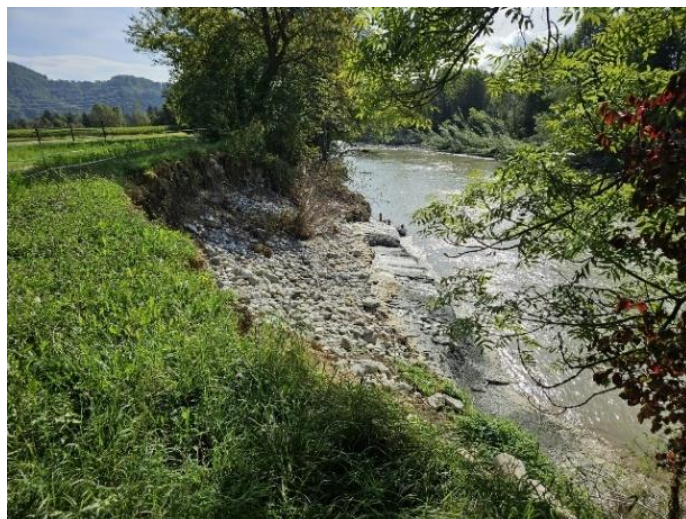
Pred izvedbo del
