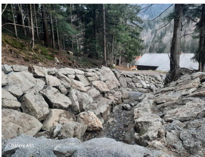
Po izvedbi del
