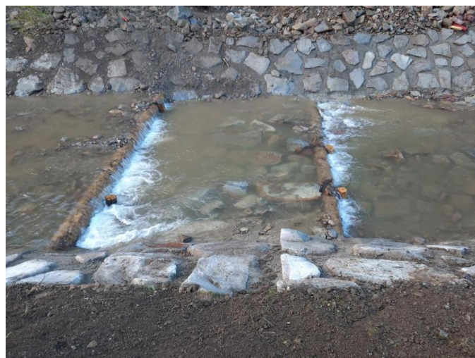
Po izvedbi del.
