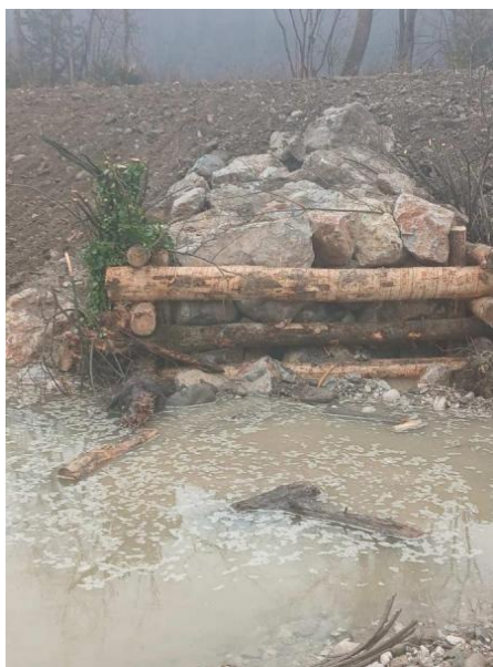
Po izvedbi del
