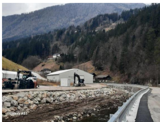
Po izvedbi del
