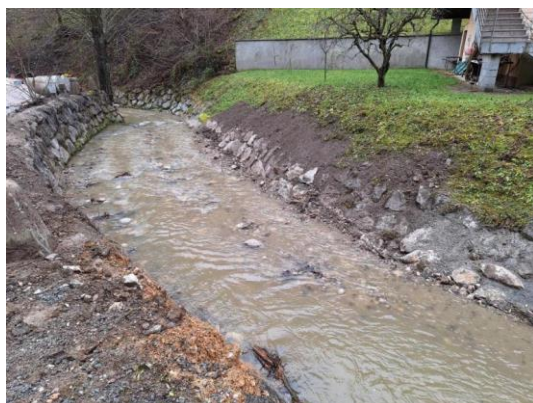
Po izvedbi del
