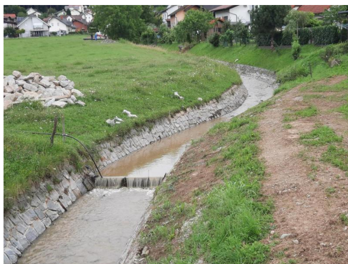
Po izvedbi del.
