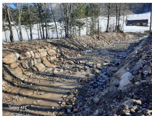
Po izvedbi del
