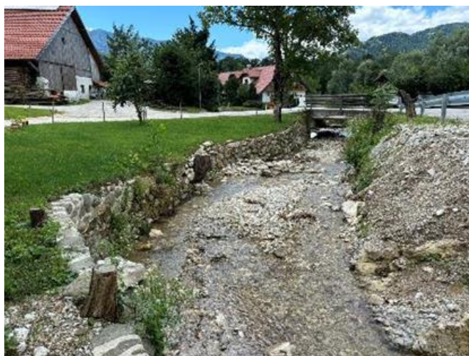
Pred izvedbo del
