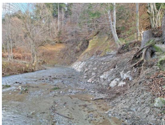
Po izvedbi del
