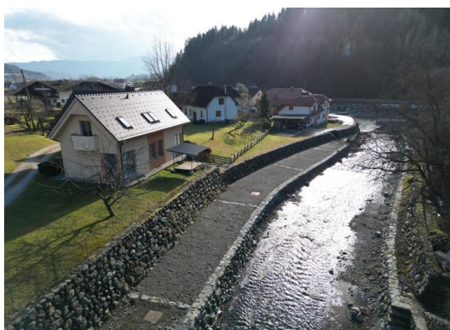
Po izvedbi del
