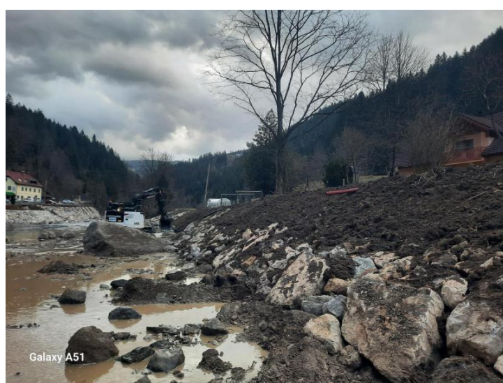
Po izvedbi del
