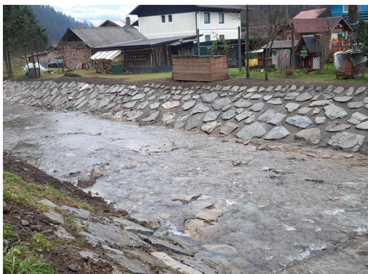
Po izvedbi del.
