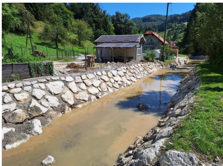
po izvedbi del
