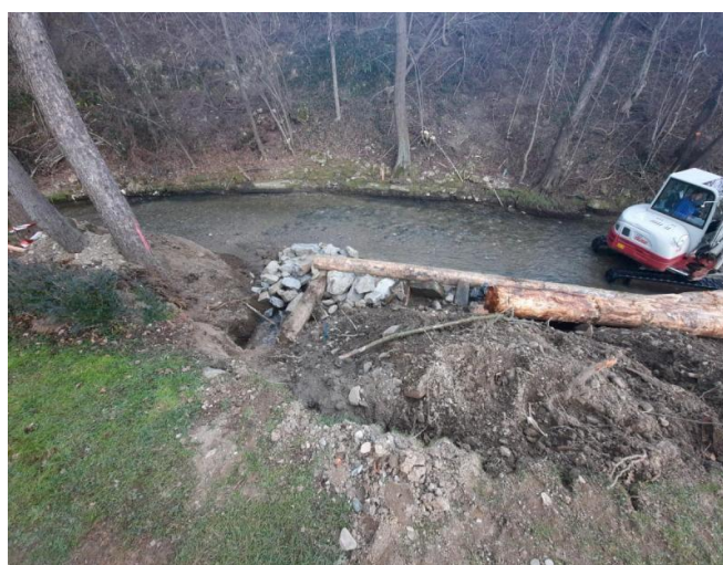
Kašta v tekom izvajanja pri hiši Dobrava 3A.
