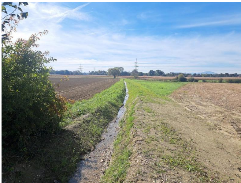
D. neimenovani pritok Vurberškega potoka po izvedbi del.
