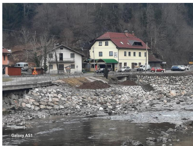
Po izvedbi del
