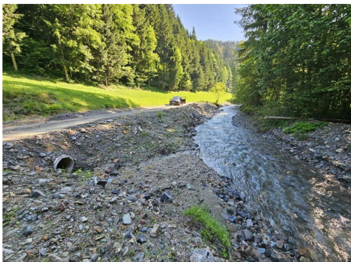
Pred izvedbo del
