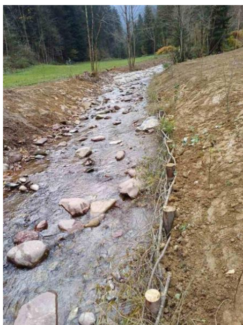
Po izvedbi del.
