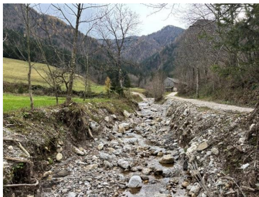
Pred izvedbo del
