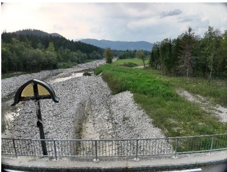
Pred izvedbo del
