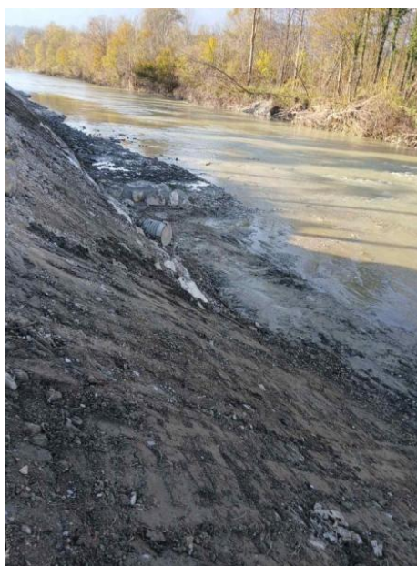
Po izvedbi del
