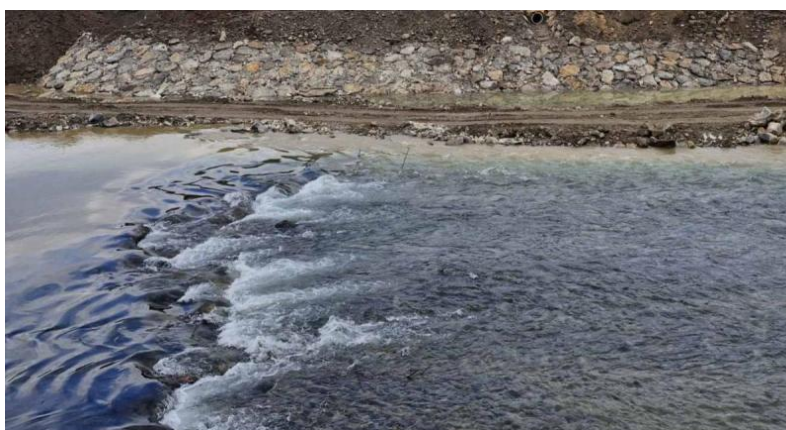
Po izvedbi sanacije
