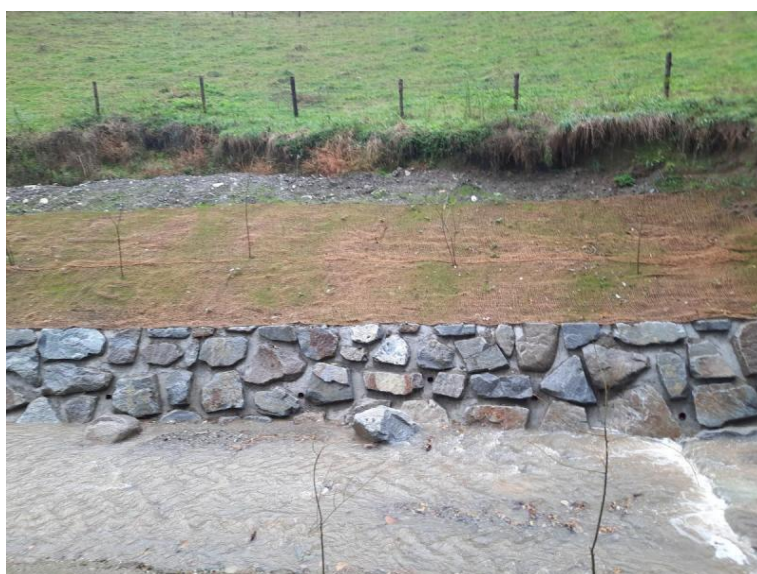
Po izvedbi del.
