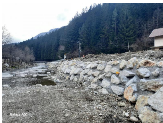
Po izvedbi del
