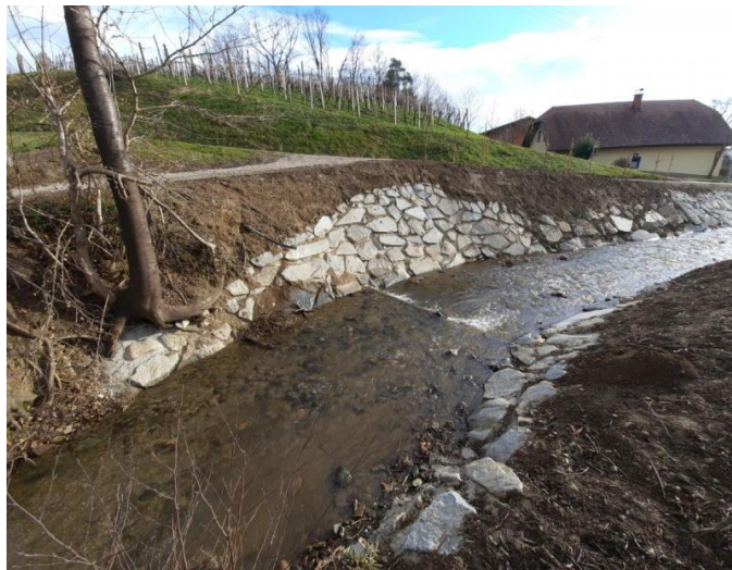
Zavarovanje bočne erozije in ustalitev dna s pragom.
