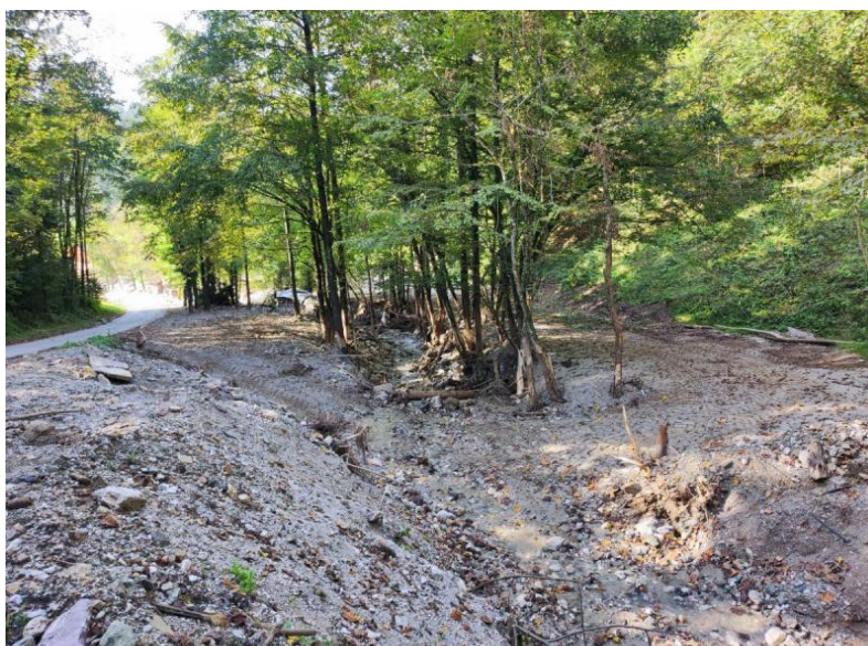
pred sanacijo in po interventnih delih
