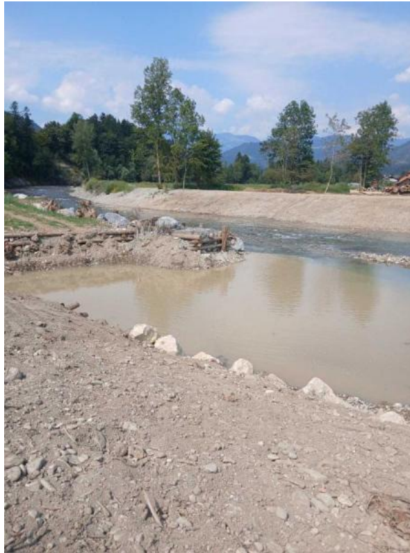
Po izvedbi del
