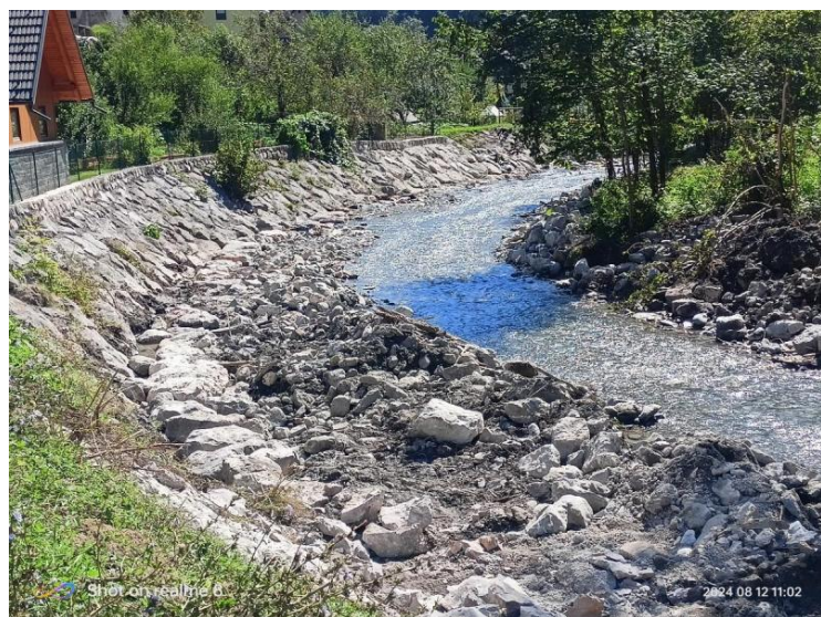
po zaključenih delih - pogled dolvodno
