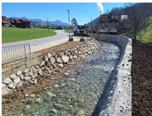
Po izvedbi del
