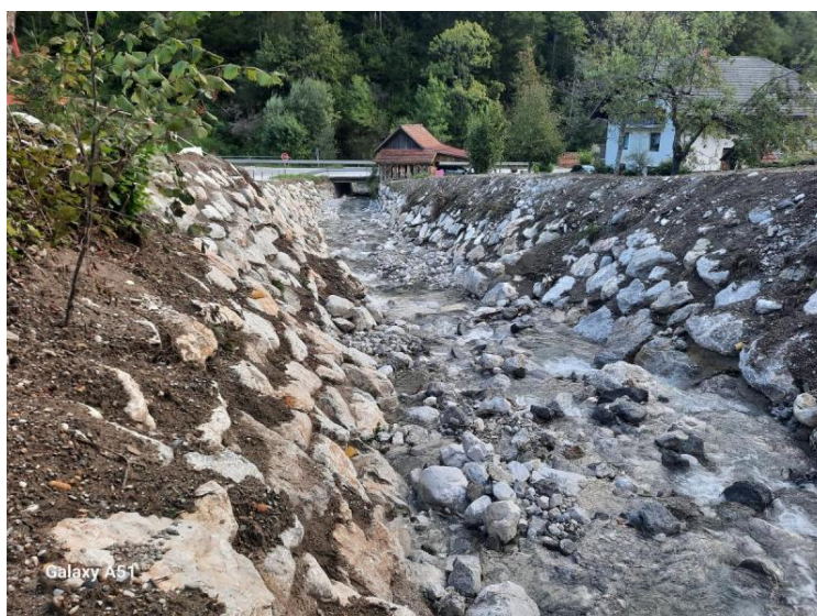
Po izvedbi del
