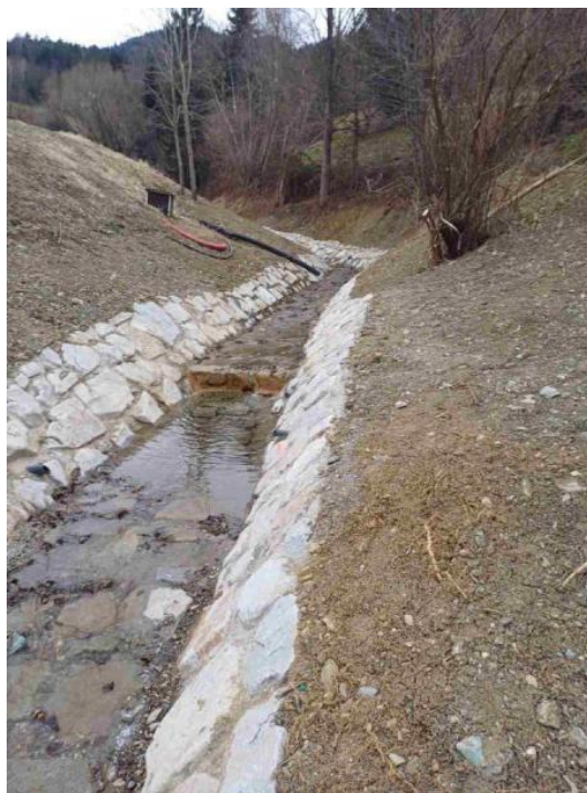
Po izvedbi del.
