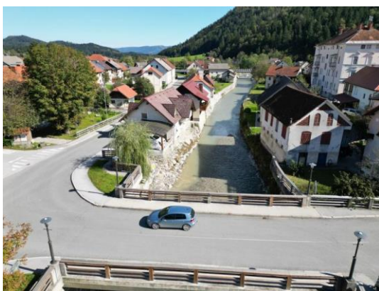
Po izvedbi del
