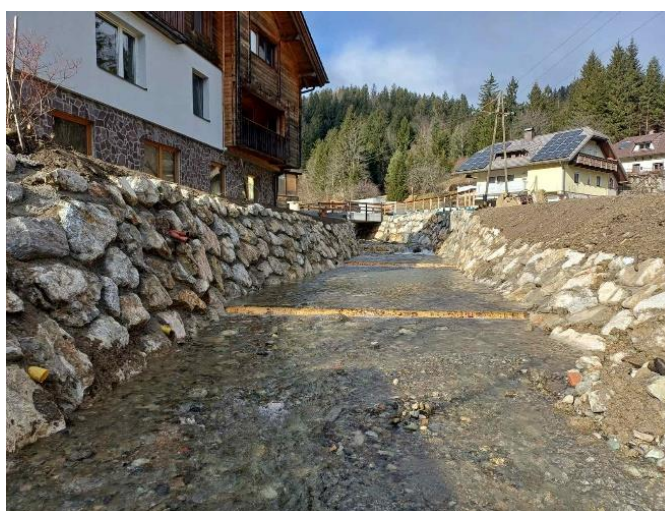
Po izvedbi del
