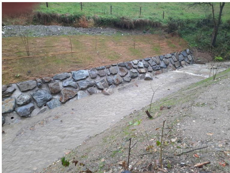
Po izvedbi del.
