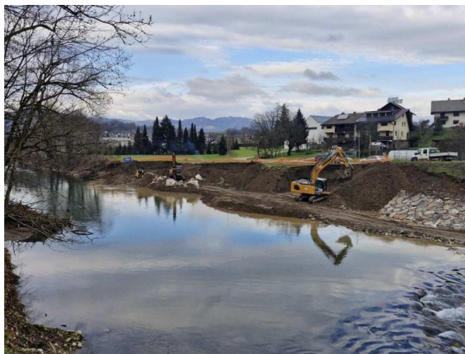
Med izvedbo - pogled gorvodno.
