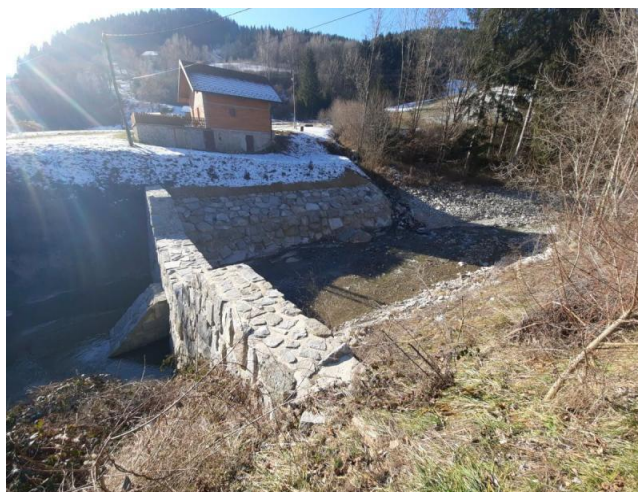
Sanacija brežin v zaledju pregrade in odstranitev naplavin iz zaplavka.
