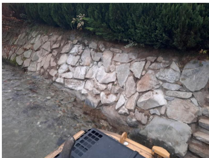
Sanacija obrežnega zavarovanja tekom izvedbe ob Rimski cesti v Sl. Konjicah.
