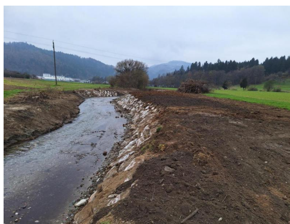
Po izvedbi del
