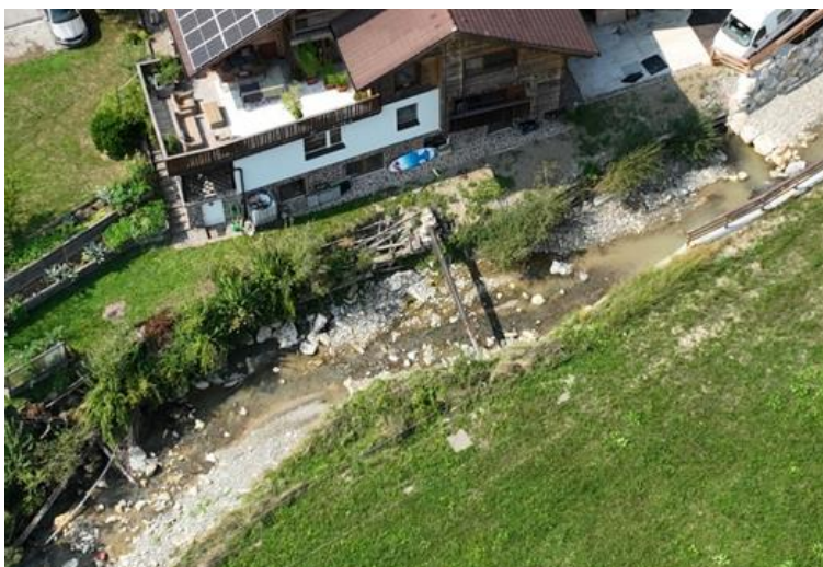
Pred izvedbo del
