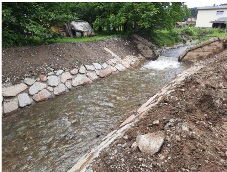
Po izvedbi del.
