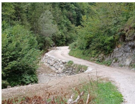
po končani sanaciji
