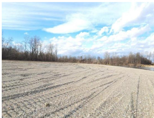
Drava - Sipina Zavrč 2 (d.b.) po izvedbi del.
