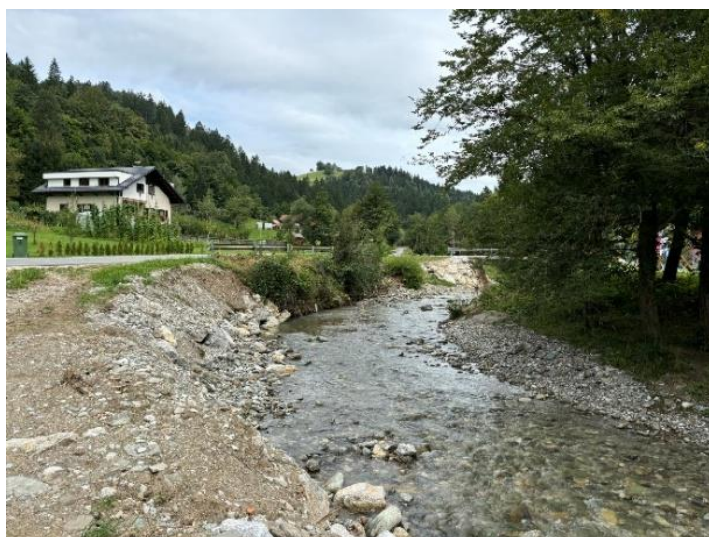
Pred izvedbo del
