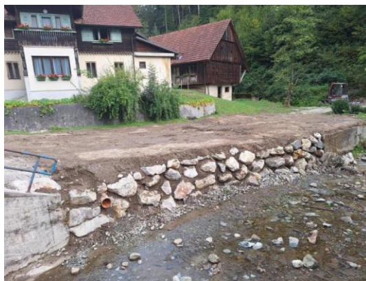
Po izvedbi del
