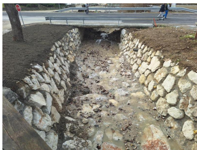
Po izvedbi del
