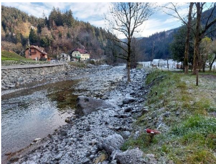
Pred izvedbo del
