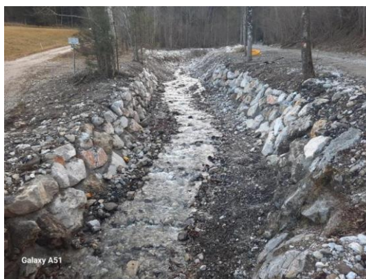
Po izvedbi del
