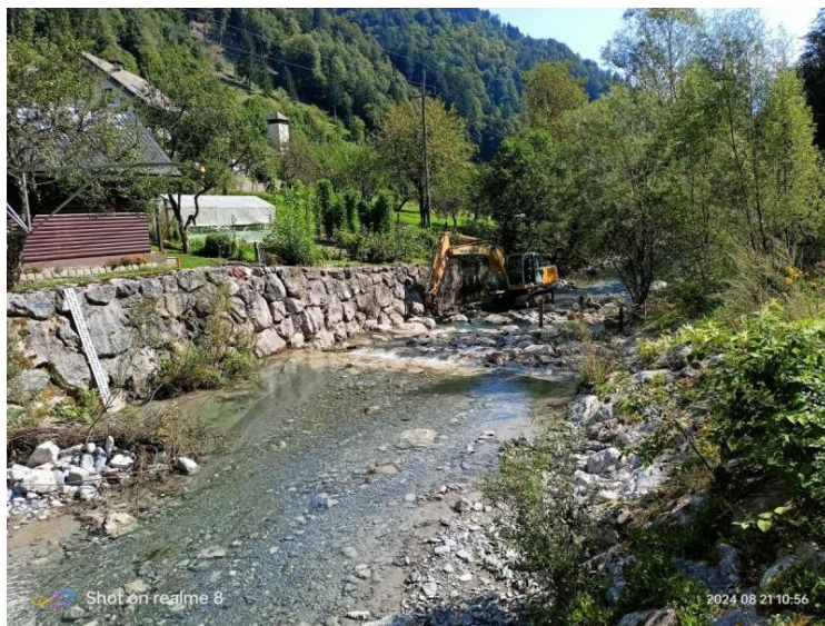
med izvajanjem del - pogled z brvi dolvodno
