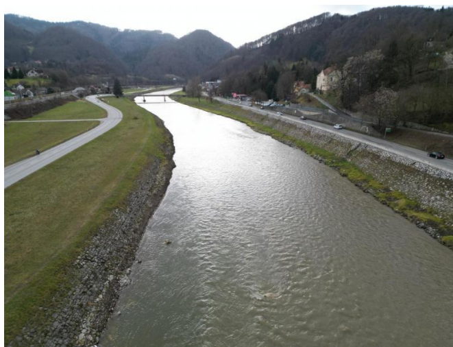
Po izvedbi del
