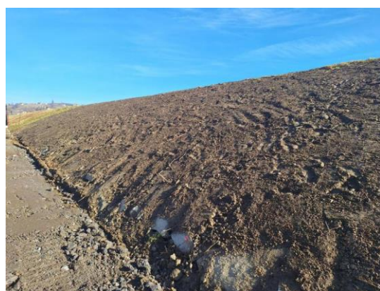
Nasip po sanaciji
