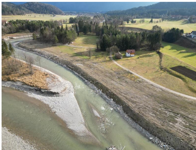
Po izvedbi del
