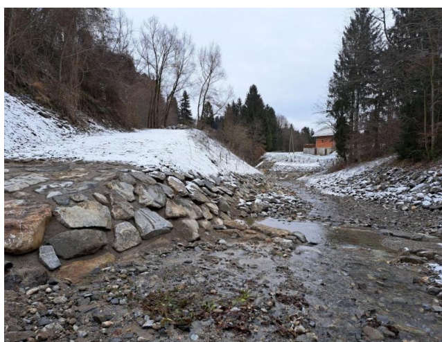
Sanacija in ustalitev struge v zaplavku pregrade in na dostopu v zaplavek.
