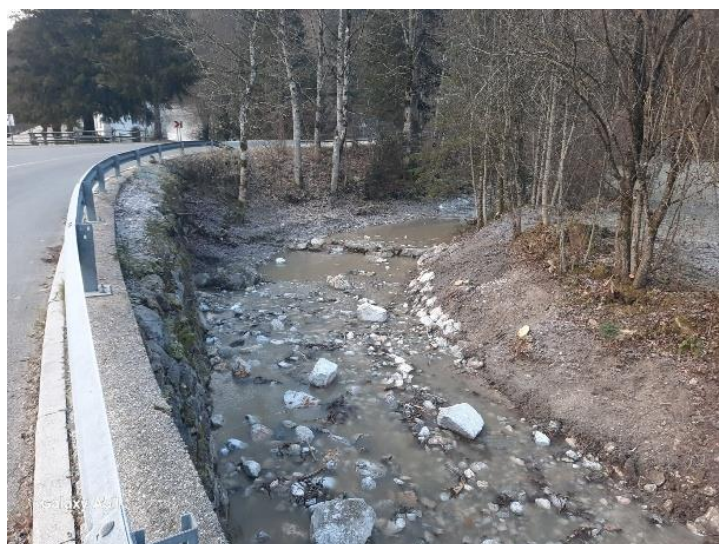
Pred izvedbo del
