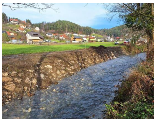
Po izvedbi del
