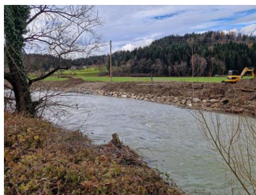
Po izvedbi del
