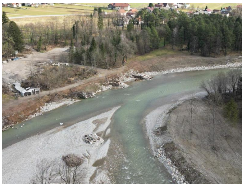
Po izvedbi del
