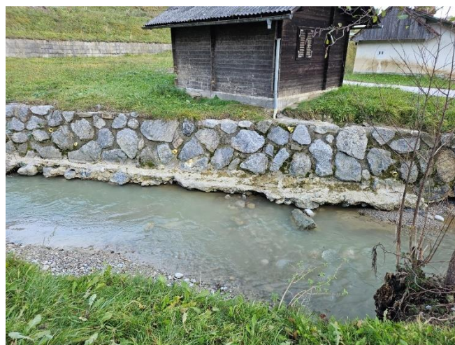
Po izvedbi del
