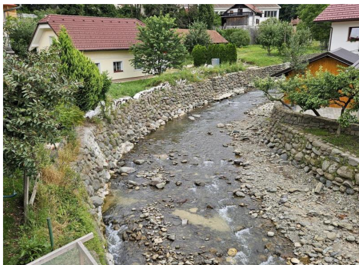
Pred izvedbo del
