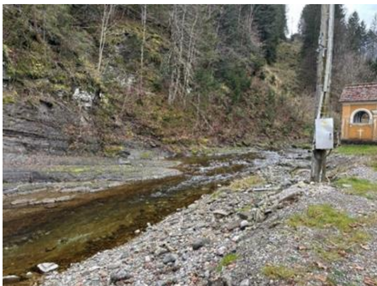
Pred izvedbo del
