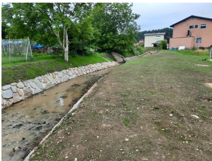
Po izvedbi del.
