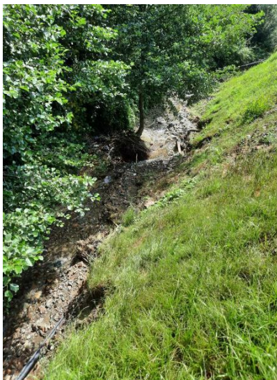
Pred izvedbo del.
