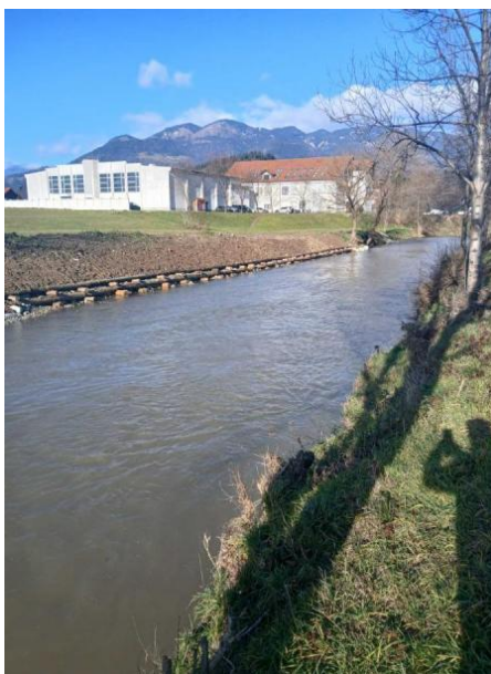
po izvedbi del
