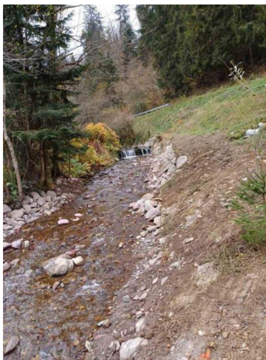
Po izvedbi del.
