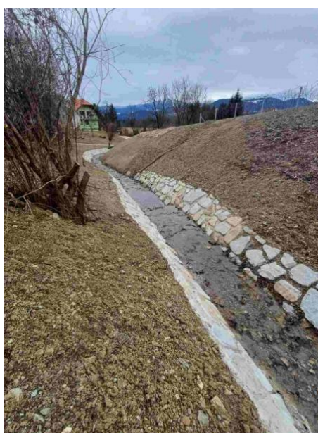
Po izvedbi del.
