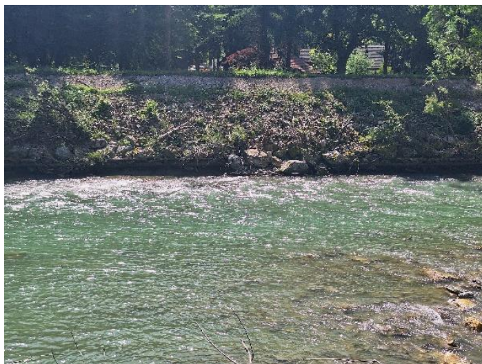
Pred izvedbo del
