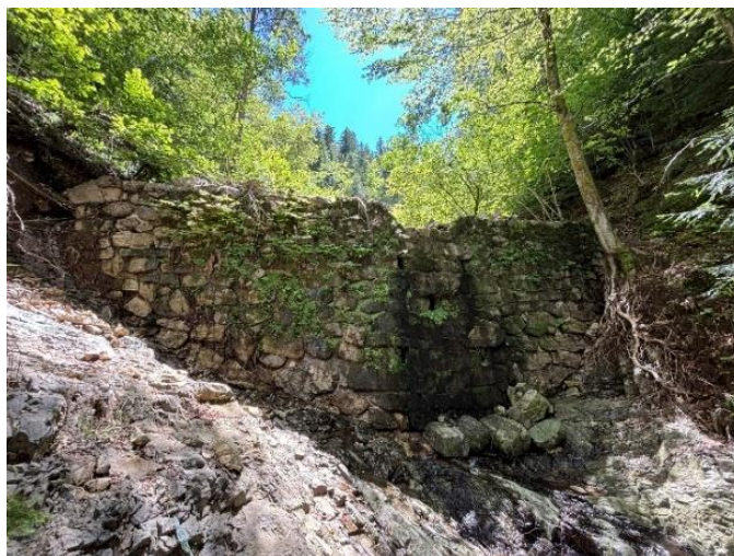
Pred izvedbo del
