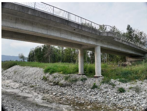
Pred izvedbo del
