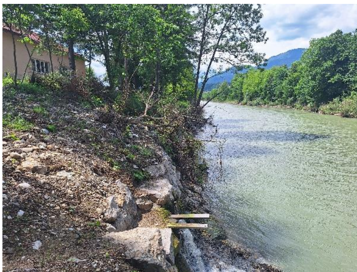
Pred izvedbo del
