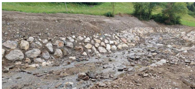
Po izvedbi del
