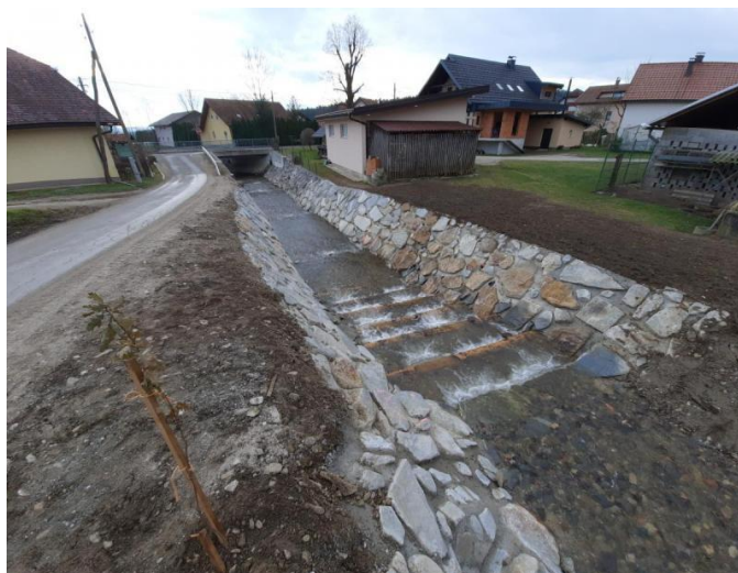
Večstopenjski leseni prag z obrežnim zavarovanjem.
