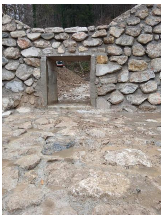
Po izvedbi del
