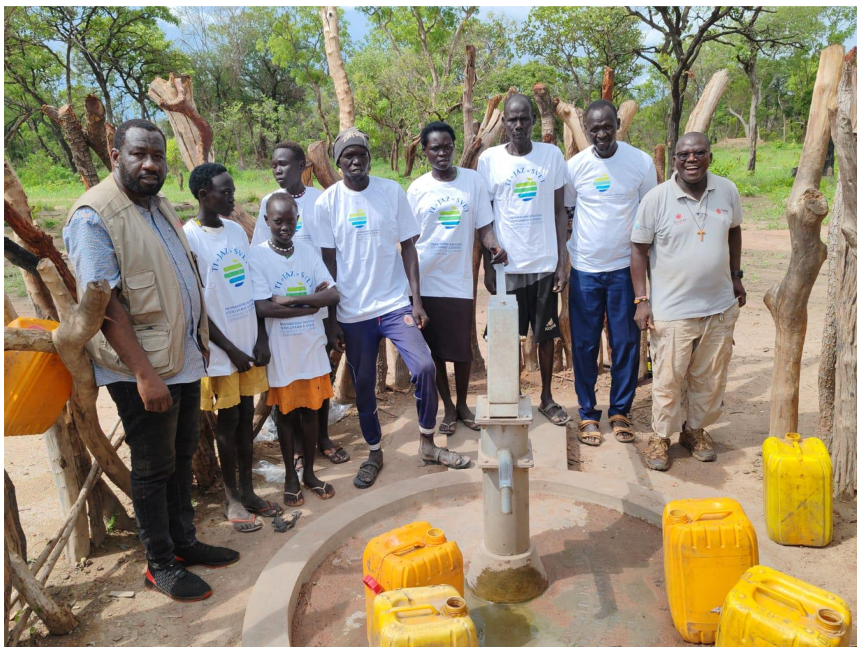
Novozgrajeni vodnjak na območju kraja Wau v Južnem Sudanu, ki daje pitno vodo 150 družinam, v katerih so preježenke porabile vsak dan 4 ure hoje, da so prišle do prvega vodnjaka. Izgrajen je bil v sklopu triletnega humanitarnega projekta, ki poteka v partnerstvu med Slovensko karitas in Karitas Južni Sudan, ki ga v letih 2023 do 2025 sofinancira MZEZ. (Foto: Slovenska karitas)
