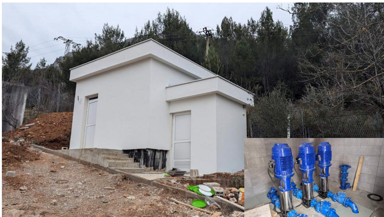
Črpališče, ki omogoča črpanje in distribucijo vode iz vodnjakov na Biletić polju do naselja Žitomislíci (Bosna in Hercegovina), s prikazom treh vertikalnih centrifugalnih črpalk. (Foto: CMSR)
