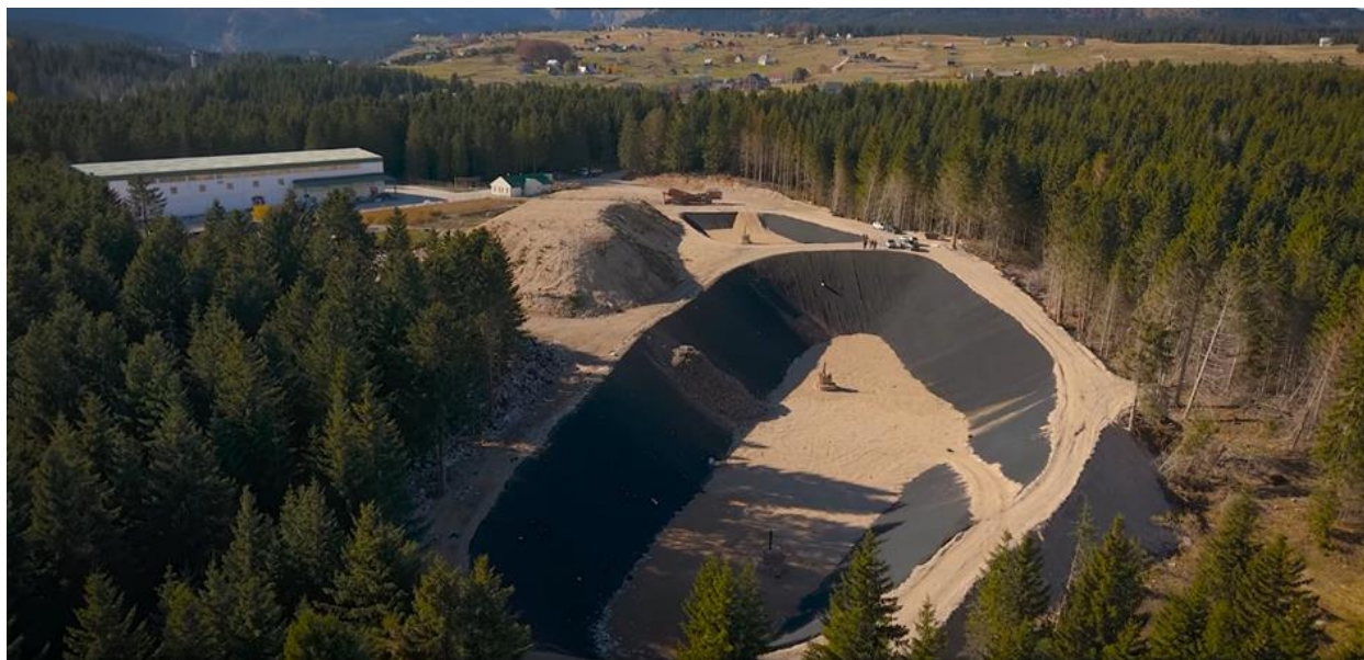
Gradnja deponije gradbenih odpadkov v občini Žabljak (Črna gora) – na fotografiji je vidno novo deponijsko polje. (Foto: CMSR)
