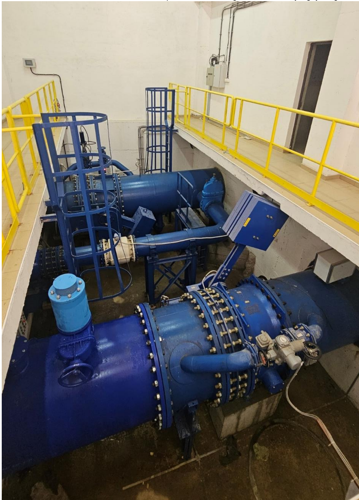
Izgradnja hidroelektrarne B na jezu Kneževu - na fotografiji je vgrajena turbina. (Foto: CMSR)
