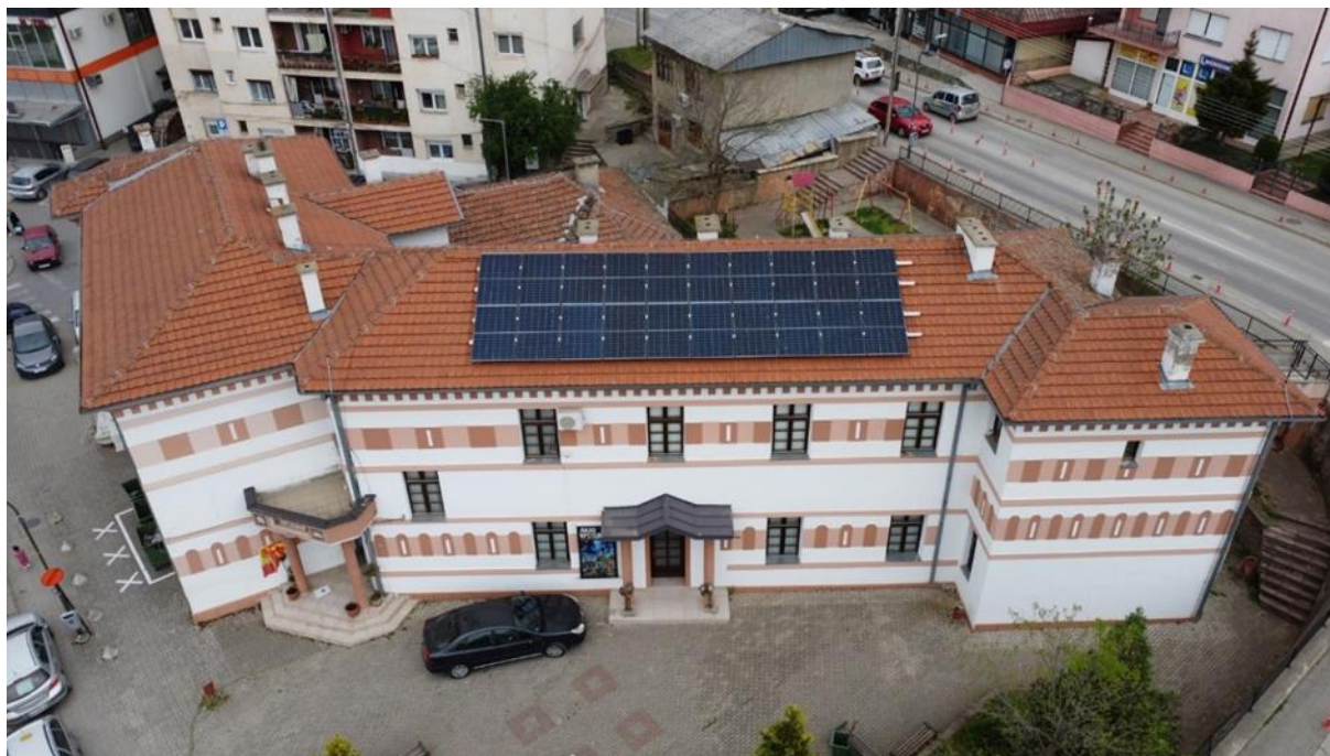
Nameščeni fotovoltaični paneli na strehi Mestnega muzeja Kriva Palanka (Severna Makedonija). (Foto: CMSR)
