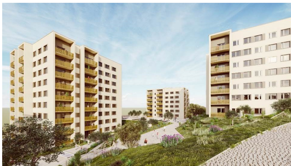
(Koper – Nad Dolinsko, gradnja)
